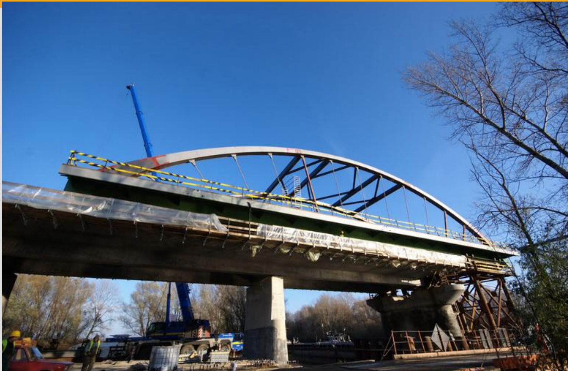
MEDER FELETTI ÚJ ACÉL FELSZERKEZET SZERELÉSE
