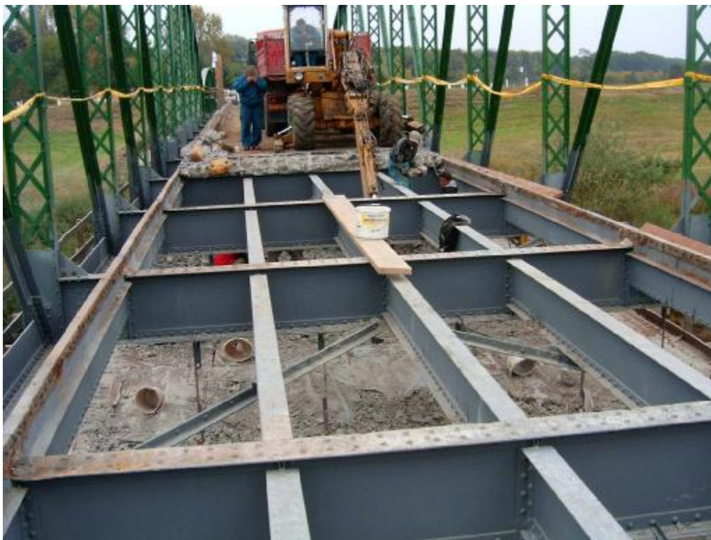
VASBETON PÁLYALEMEZ BONTÁSA
