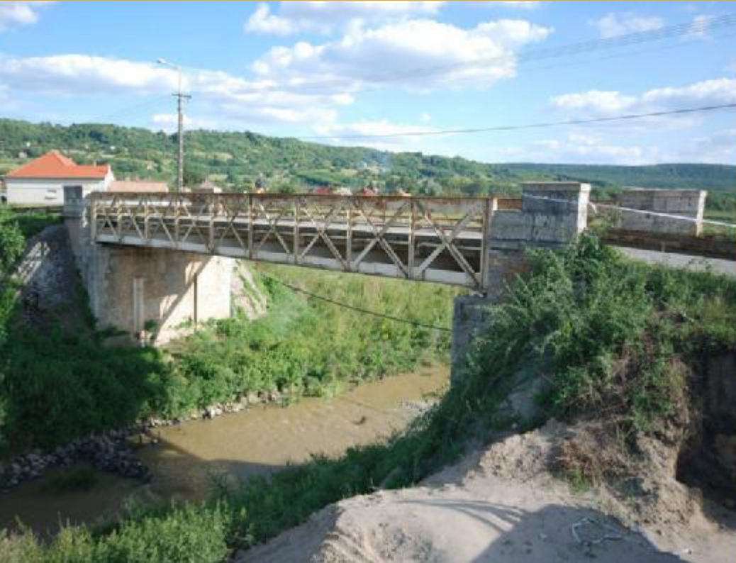
DÖBRÖKÖZI KAPOS HÍD AZ ÁTÉPÍTÉS ELŐTT
