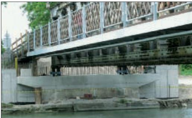
12. kép: Az alépitmények már átépültek a gyalogosforgalmat még lebonyolító provizórium alatt
