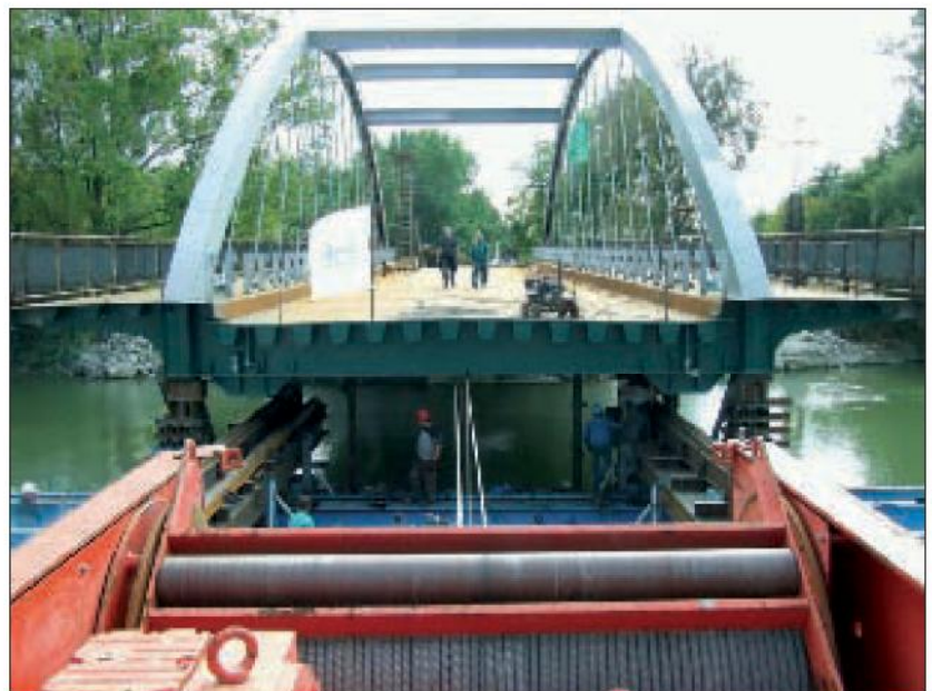
20. kép: A felszerkezet behúzása csörlővel
