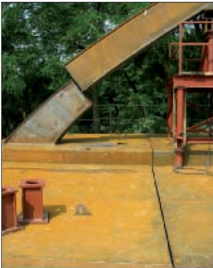
17. kép: A pályatáblák illetve, hegesztéshez előkészítve, az ív ívcsonkra mozgatása folyamatban
