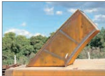
15. kép: Ívcsonk – pályalemez próbaillesztése
