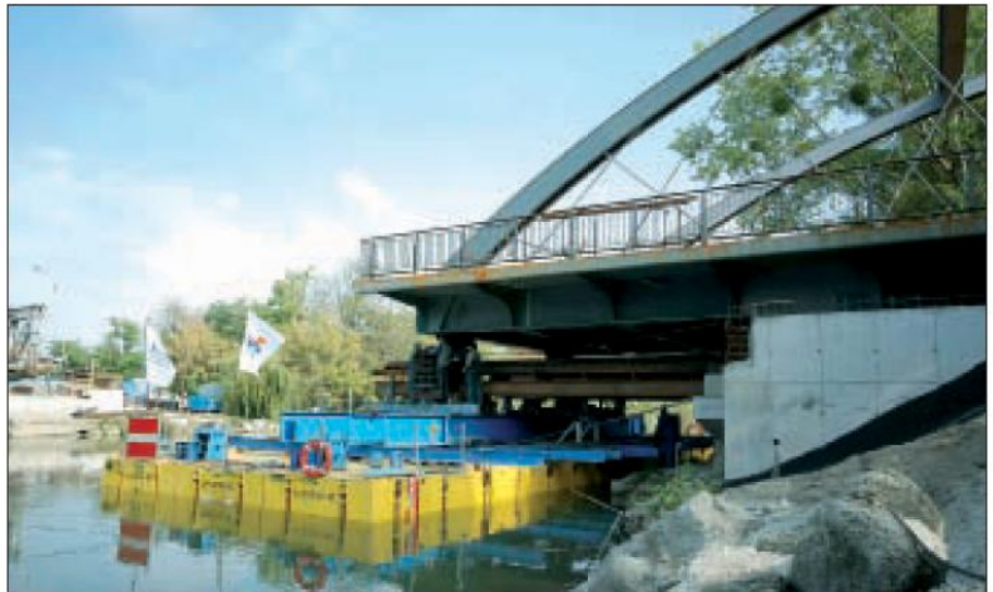
19. kép: Az új felszerkezet beúsztatása
