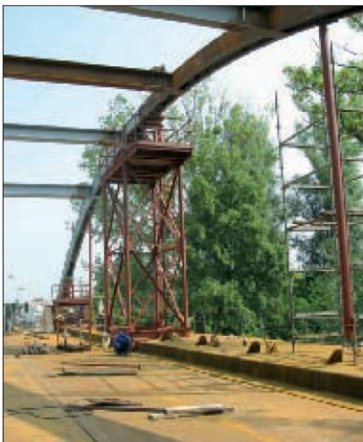
18. kép: A szerelőtéren elkészített felszerkezet
