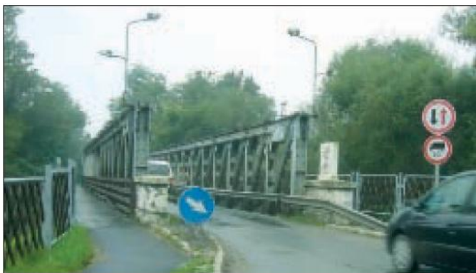
3. kép: Az elégtelen keresztmetszetű provizórium csak egyirányú forgalom átvezetésére volt alkalmas
