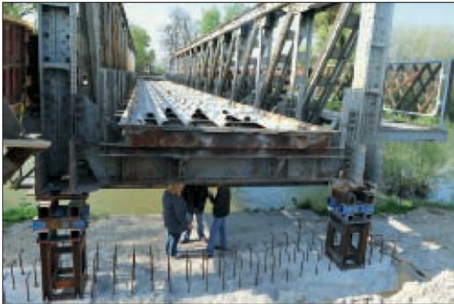
11. kép: Elbontandó provizórium megemelése – felmenő szerkezet átépítése alatt a gyalogos és kerékpáros forgalom a provizóriumon halad
