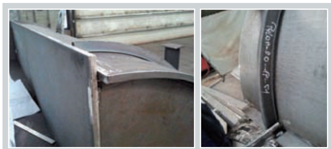
8. ábra: Pilontalpak gyártás közben (Bilfinger MCE Nyíregyháza Kft.)
