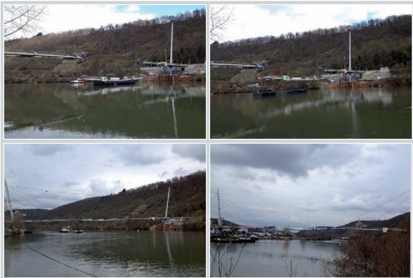
11. ábra: Záróelem beúsztatása és beemelése (Harrer Ing.)
