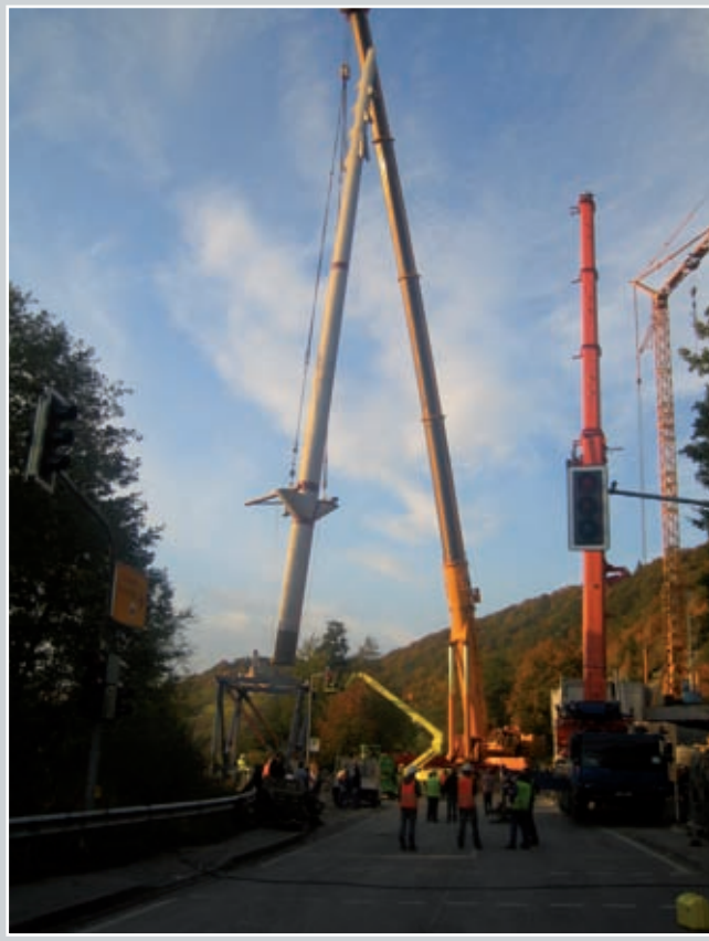
9. ábra: A 30. pilon beemelése (Bilfinger MCE GmbH)
