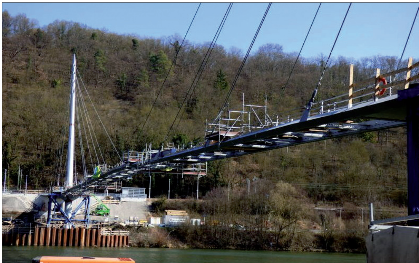
1. ábra: A híd merevítőtartójának szerelése
