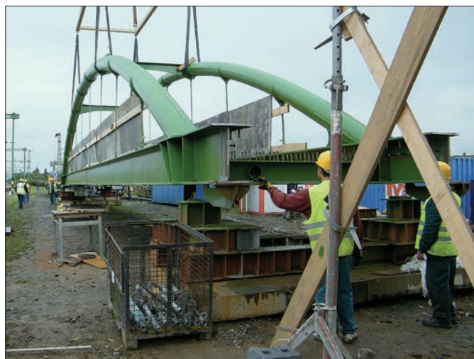
13. ábra: A vágányok mellett kialakított szerelőtéren elhelyezett ívekkel merevített szélső nyílás eleme
