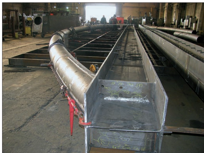
12. ábra: A kifektetett első ütemű főtartók a KÖZGÉP Zrt. Haraszti úti telepén
