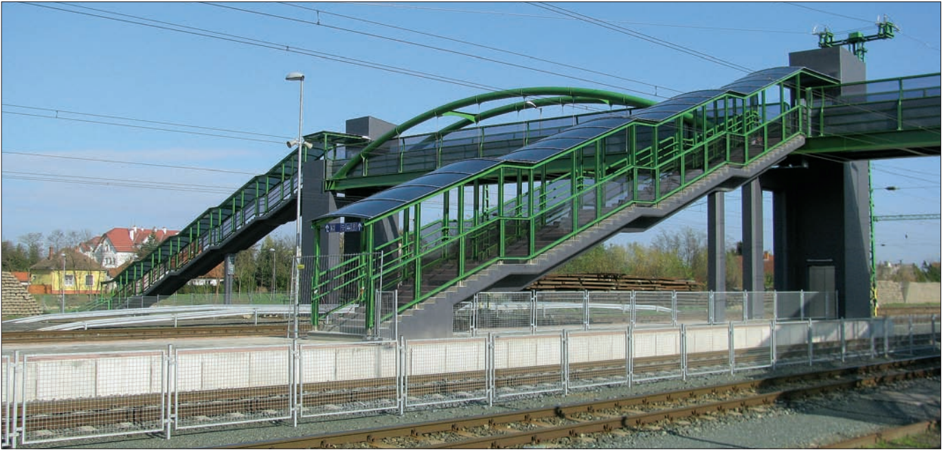
9. ábra: Az első ütemben elkészült vasút feletti, ívvel merevített szélső felszerkezeti nyílás és a T1 és T2 fedett lépcsőkarok
