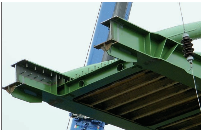
15. ábra: A támaszkereszttartó és ívválak környezete a főtartóra felhelyezett nyírófogakkal
