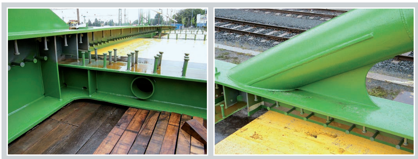
5. ábra: Az acél merevítőtartó kialakítása és az íváll környezet még a vasbeton pálya nélkül
