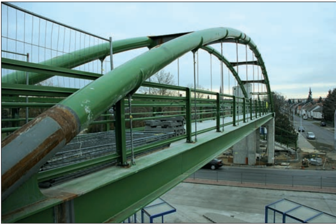
18. ábra: A második ütemben elkészült buszpályaudvar fölötti nyílás szerkezetkész állapotban, épülő korlátokkal
