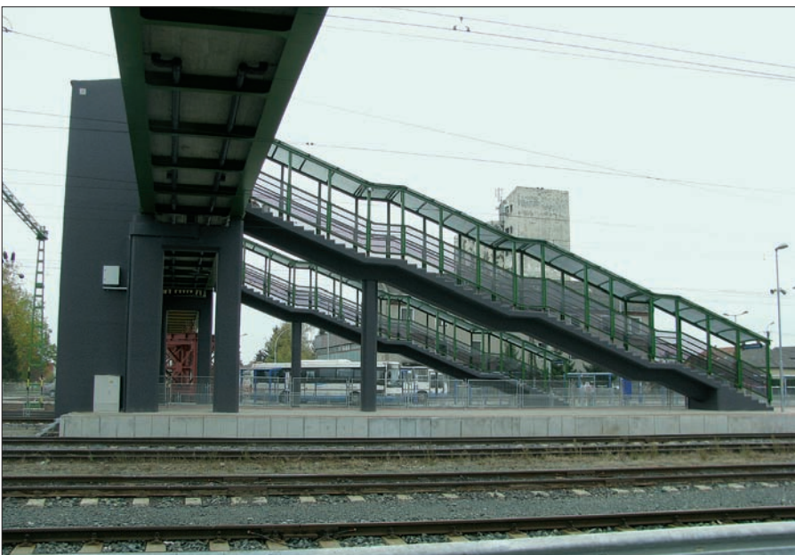
10. ábra: A T2 és T3 konzolosan kapcsolódó fedett lépcsőkarok
