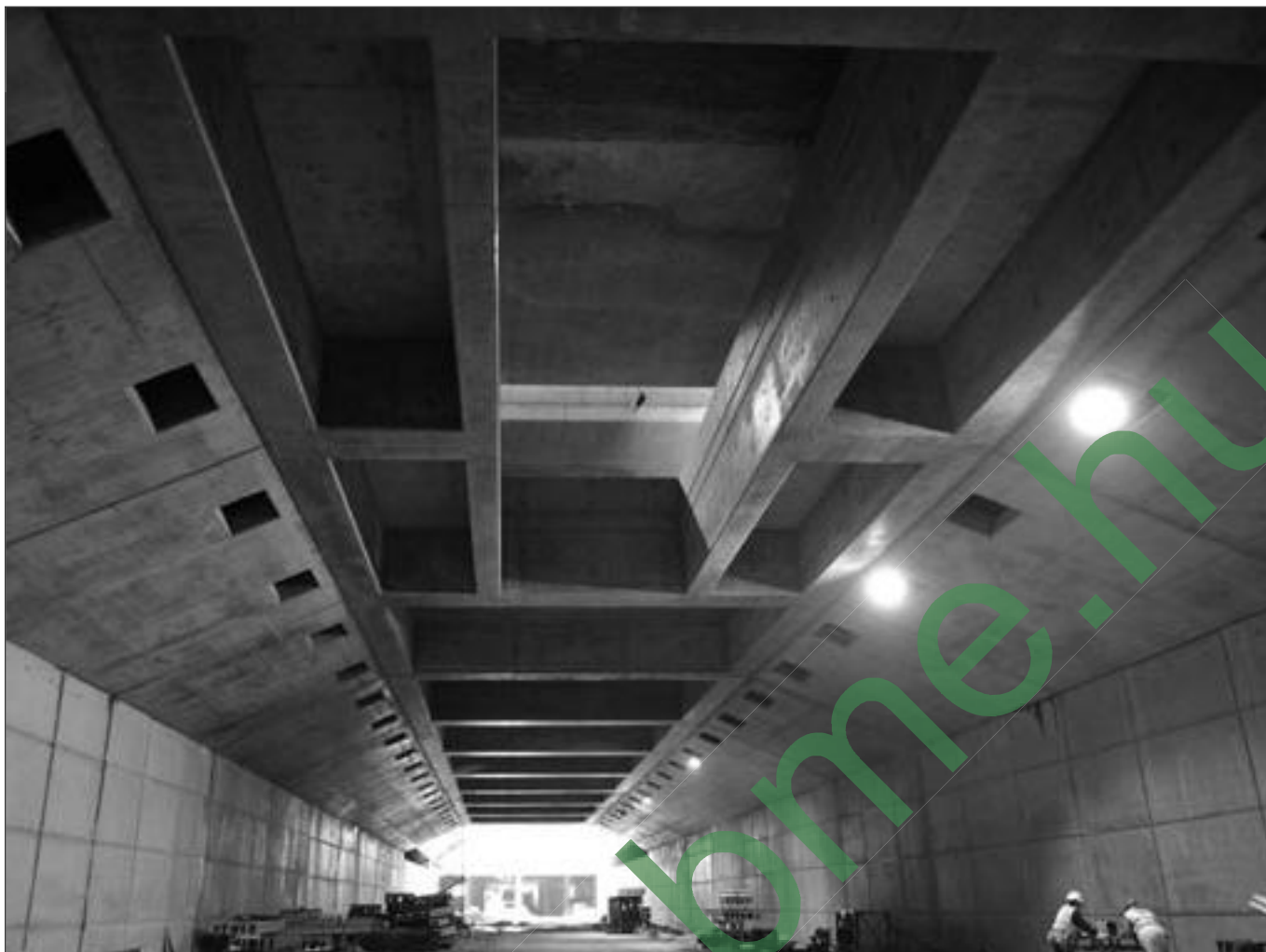
10. ábra: Alulbordás vasbeton födém
