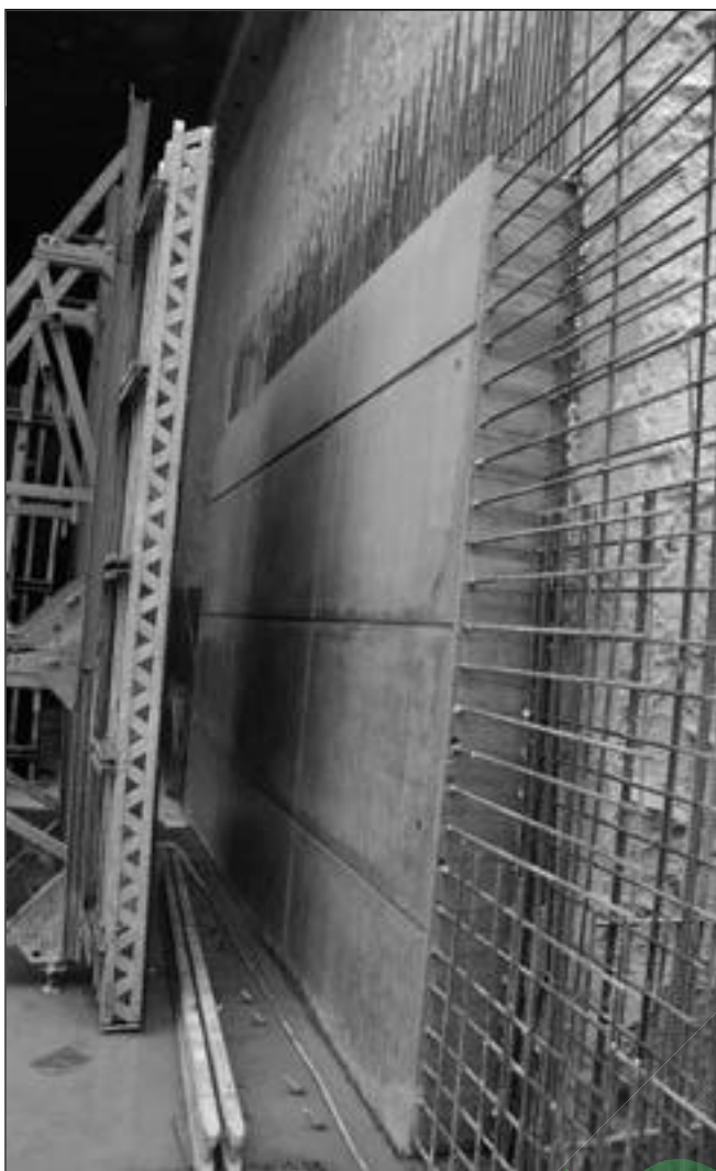
4. ábra: Látszó-betonfelület kivitelezése
