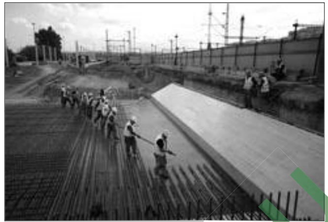
8. ábra: Monolit vasbeton lemezhidák vasszerelése, látszóbeton zsaluzat
