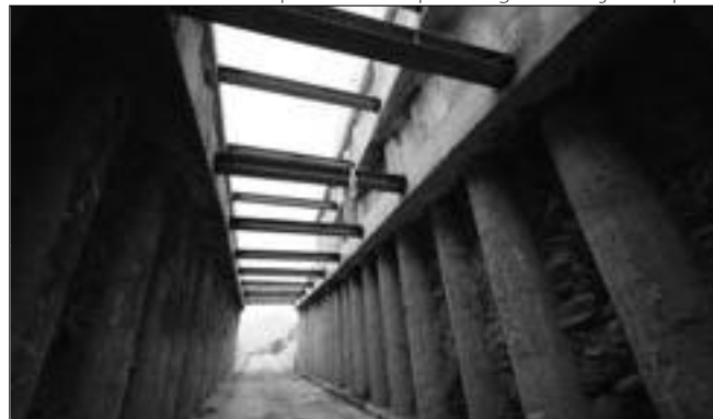
11. ábra: Kitámasztott cölöpfalak között épülő ideiglenes lejáró-rámpa
