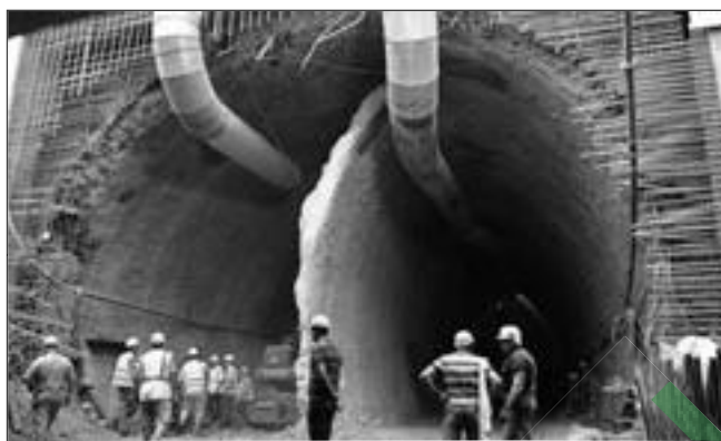
13. ábra: Bányászati módszerrel épülő alagút építése, a második építési ütem fejtése elkezdve, még az első „szilvamarag” alakú lött-beton kéreg belső fala nincs elbontva
