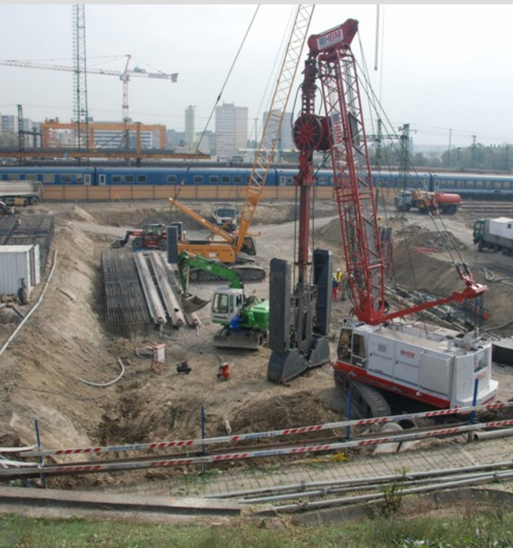
RÉSFALAK ÉPÍTÉSE
