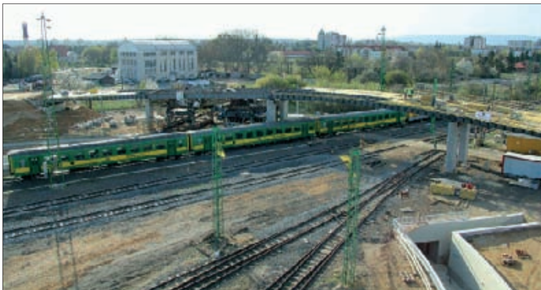
22. kép: A felszerkezet félig beüzemelt
