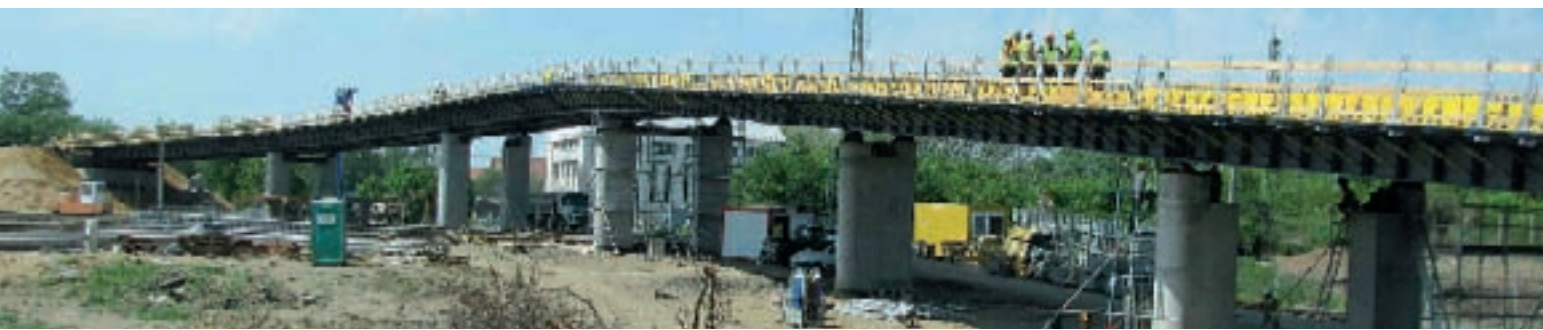
5. kép: Oldalnézet az épülő híddal
