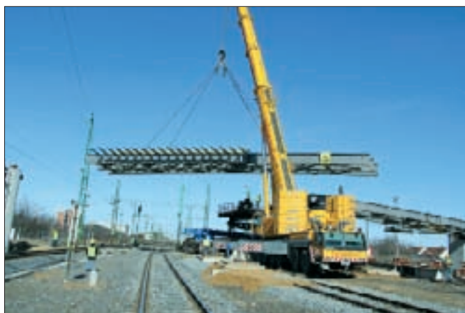
17. kép: Közbenső nyílás beemelése
