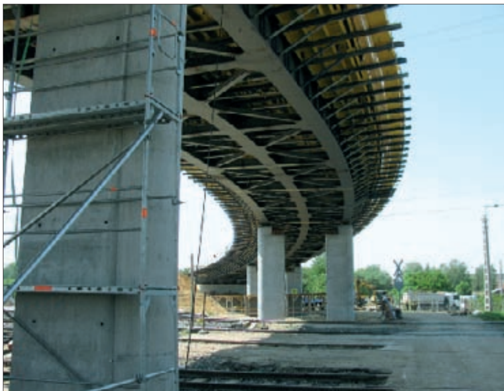
11. kép: Acélszerkezet beemelése a vízszintes sík rácsrudak nélkül
