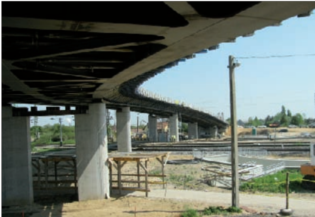
23. kép: A felszerkezet teljesen beüzemelt
