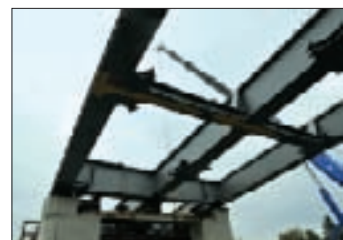
11. kép: Acélszerkezet beemelése a vízszintes sík rácsrudak nélkül
