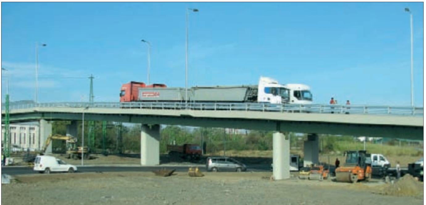
18. kép: Próbaterhelés
