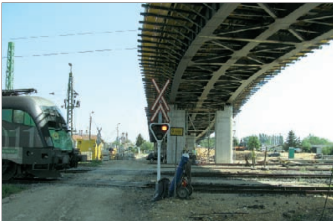
2. kép: Építési állapotban üzemelő szintbéli átjáró már az épülő új felüljáróval
