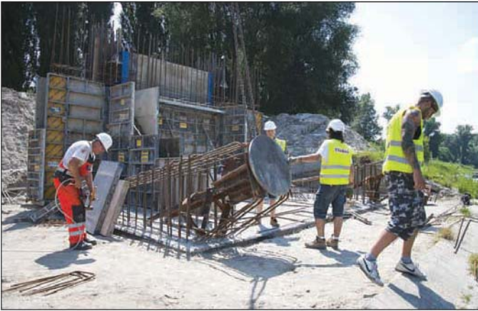
10. kép: Acélső ívet fogadó szerelvény elhelyezése a vasbeton cölöpösszefogóban
