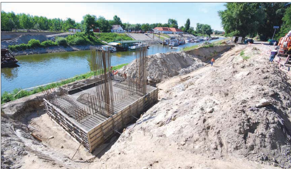
8. kép: Cölöfemek és elkezdett cölöpösszefogó betonacél szerelése, láthatóak a cölöpfejekben elhelyezett acél tartóbetétek
