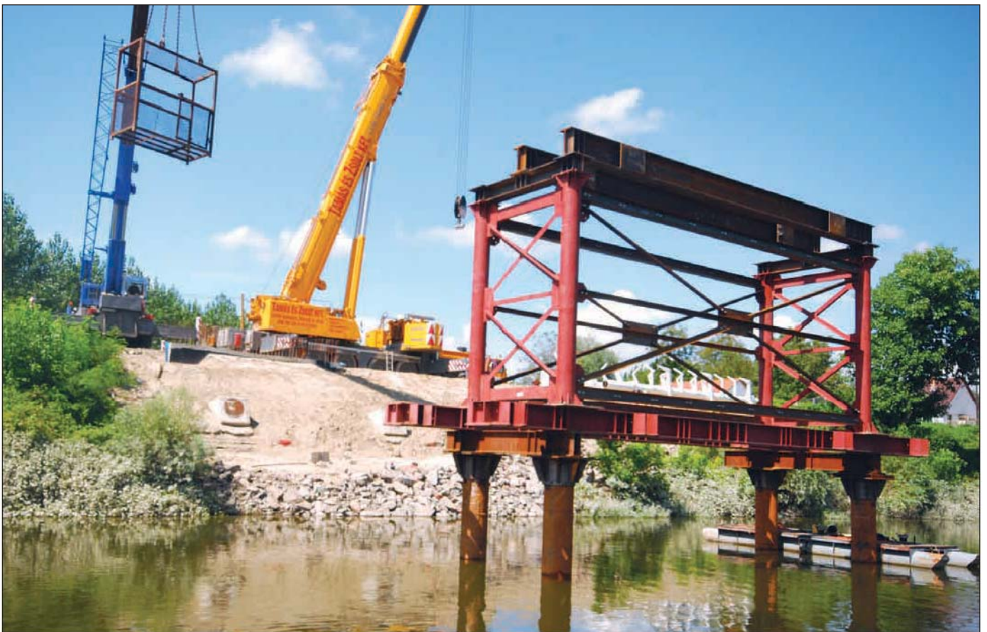
15. kép: Csőcölöpök a mederben
