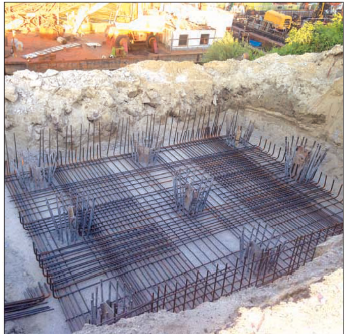
8. kép: Cölöfemek és elkezdett cölöpösszefogó betonacél szerelése, láthatóak a cölöpfejekben elhelyezett acél tartóbetétek
