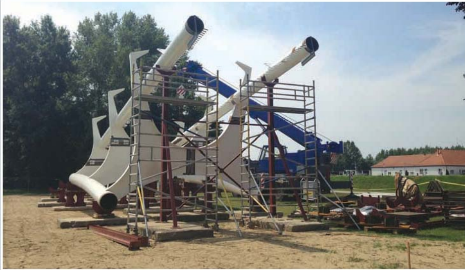
14. kép: Helyszíni szerelés: szállítási elemek beemelési egységgyé illesztése
