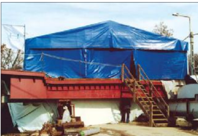
19. kép: A második sátor is kész, látható a végkereszttartó és az alatta lévő térelhatároló függöny (2006.02.20.)
