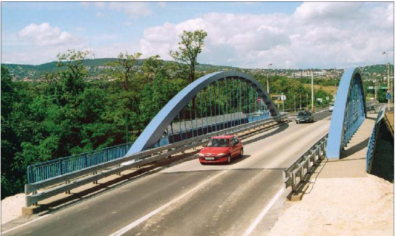
50. kép: A kész híd
