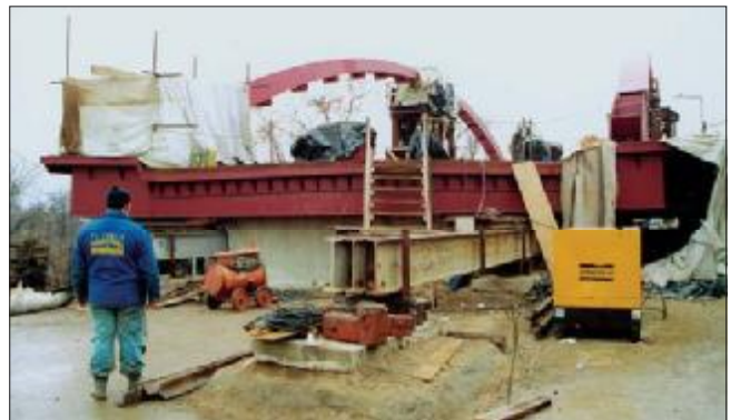
32. kép: A beemelt ívek a csomknál és a középső illesztésnél felépített sátrakkal
