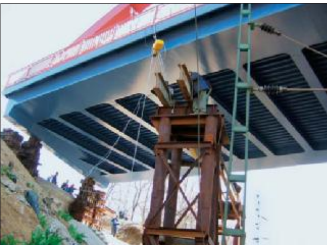
42. kép: A betolópályát alátámasztó állványok bontása
