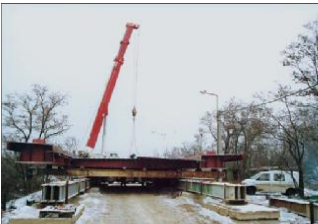
15. kép: A szerelőpad, annak pesti oldali végén az első két hídgyésséggel (2006.01.18.)
