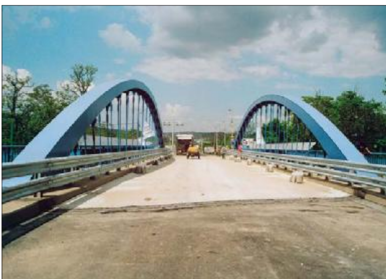
45. kép: A vasbeton pályaburkolat érdesítés előtt (2006.05.03.)
