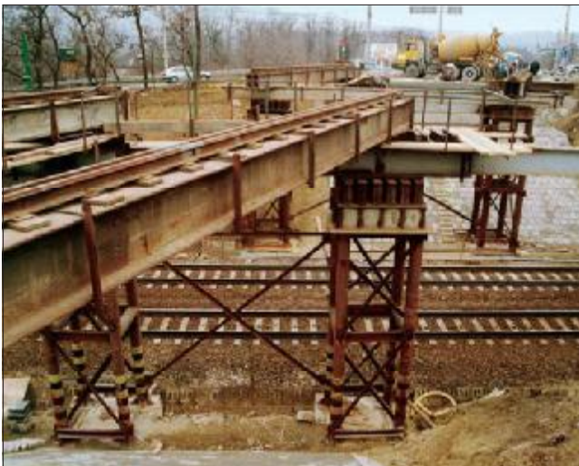
37. kép: A betolópálya az alátámasztó oszlopszerkezetekkel
