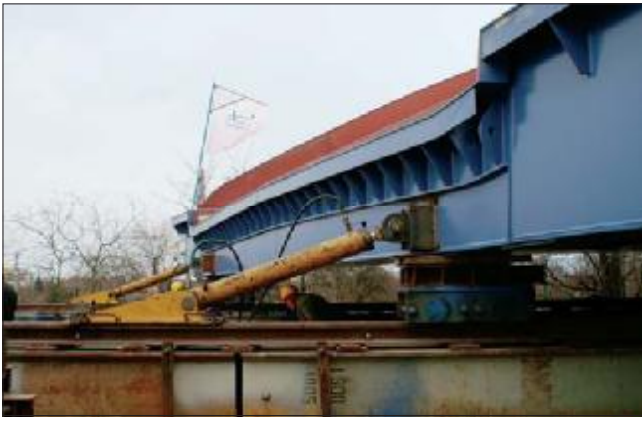
38. kép: A híd betolására szolgáló hidraulikus sajtók
