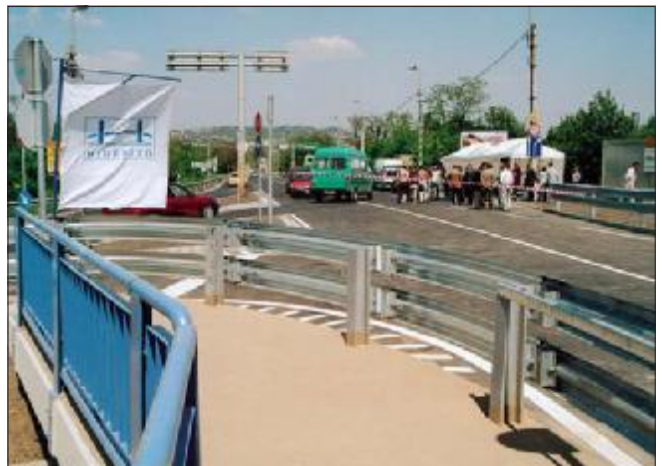
49. kép: Átadás a pesti oldali hídvég felől szemlélve (2006.05.12.)
