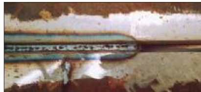
23. kép: A pályalemez hosszvarratának MAG eljárással készült alapsora
