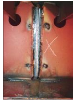
27. kép: Az elkészült gerincillesztés varratának gyöksora
