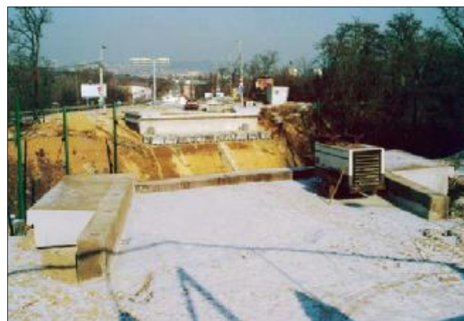
6. kép: Az újjáépített hídfők
