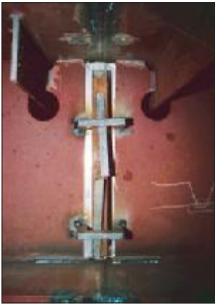
24. kép: A keresztartó gerinc kötésének hegesztéséhez felszerelt kerámia alátét
