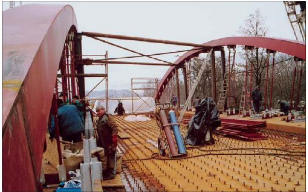
35. kép: Az íveket a behúzás alatti igénybevételekre ideiglenesen beépített alátámasztó és kereszt-kötésrendszer (2006.03.31.)
