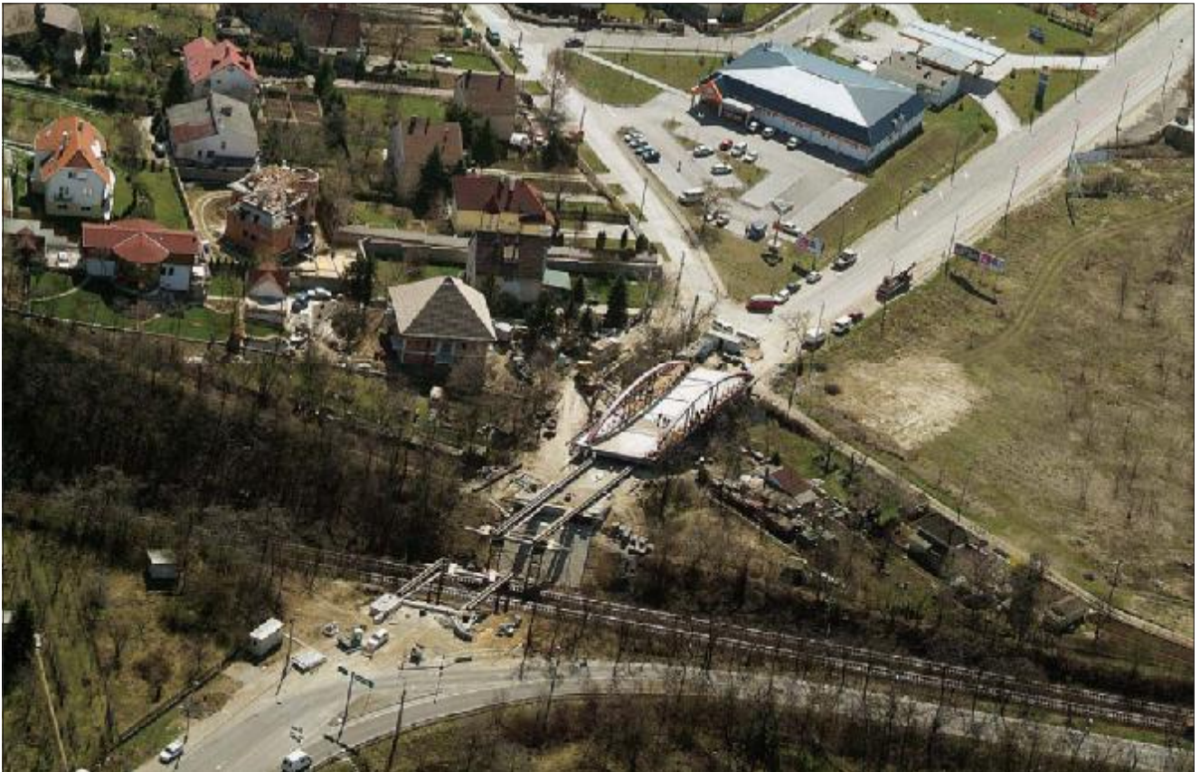
1. kép: A hídépítés helyszíne madártávlatból
