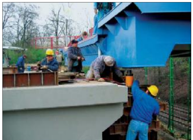
43. kép: A hídszerkezet süllyesztése 2x2 db máglya és 2x2 db 100 tonnás hidraulikus sajtó segítségével
