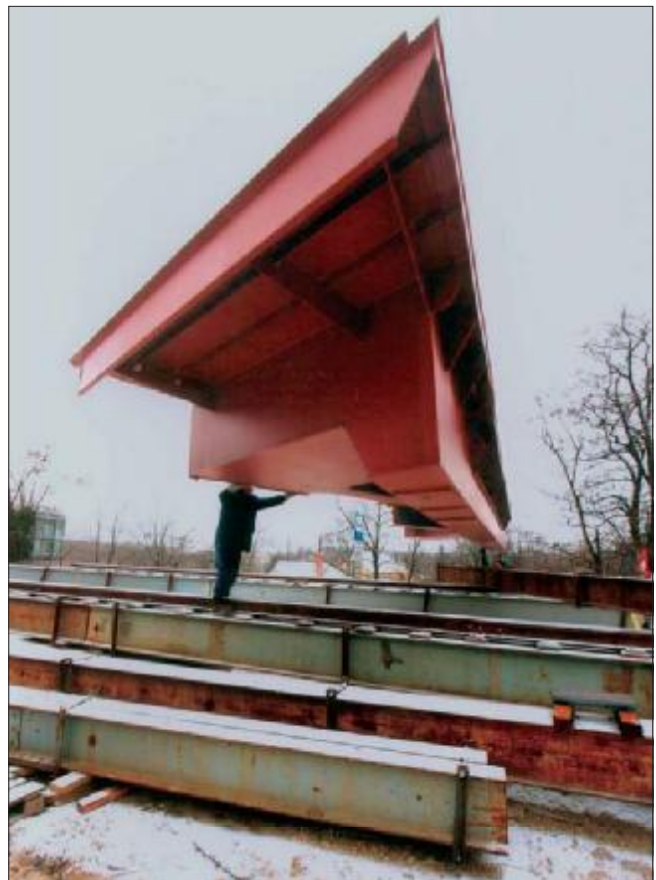
16. kép: A végkeresztartó beemelése (2006.01.17.)
