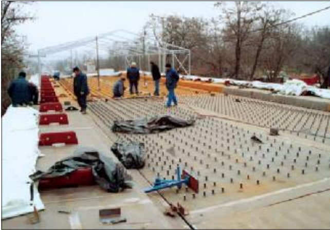
17. kép: A merevítőtartó egységei a helyükön vannak, épül a sátorváz (2006.01.31.)
