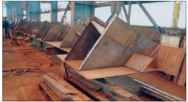
10. kép: A végkereszttartó összeállítás alatt
