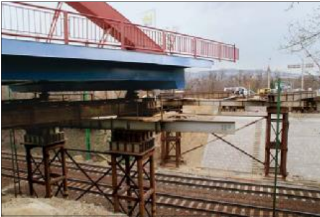
39. kép: A betolópálya és a híd a mozgatási művelet ütemében
