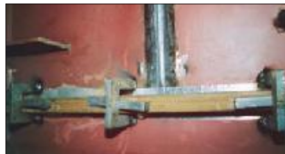
21. kép: A pályalemez alulnézetben, a keresztirányú varrat gyöke és a hosszvarrat fürdő biztosításául szolgáló kerámia alátét a felszorító eszközökkel
