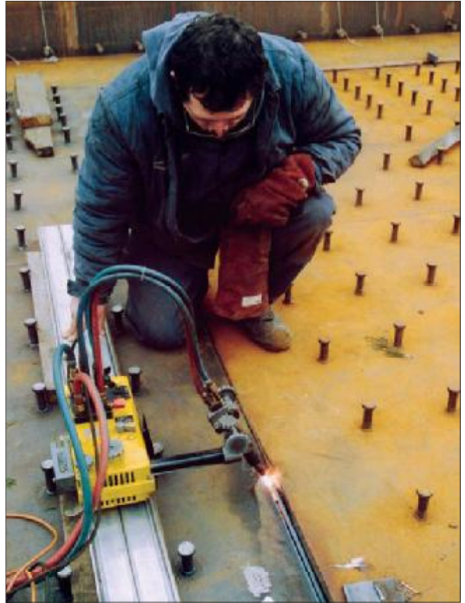
20. kép: A pályalemez pontos mérethez szabása autogén székátorral
