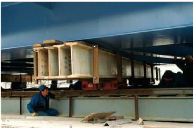
36. kép: A híd konzolos alátámasztása és a behúzó kocsi az Érd felőli kis tengelytávolságú pályaszakaszon
