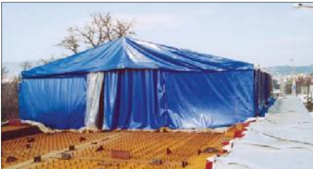
18. kép: A pesti oldali sátor az oldalsó térelhatároló függönyökkel (2006.02.13.)
