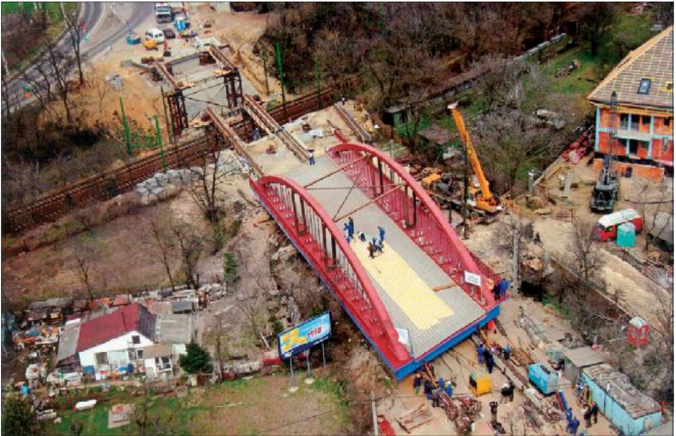
14. kép: A szerelőtér a már betolásra előkészített híddal (a helyszűke jól érzékelhető)
