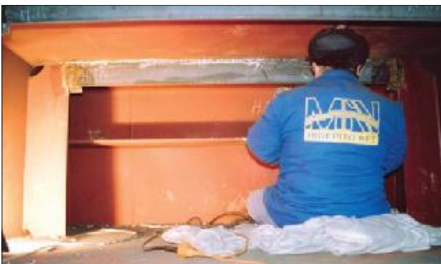
31. kép: A főtartó belső gerincének hegesztése (a külső gerinc „ablakos” illesztése felől szemlélve)
