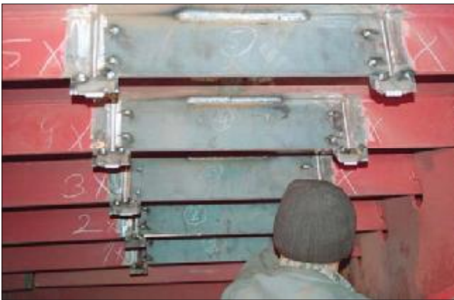
28. kép: A laposacél hosszborða „ablakos” illesztőeleme hegesztéshez kerámiafürdő biztosítással előkészítve
