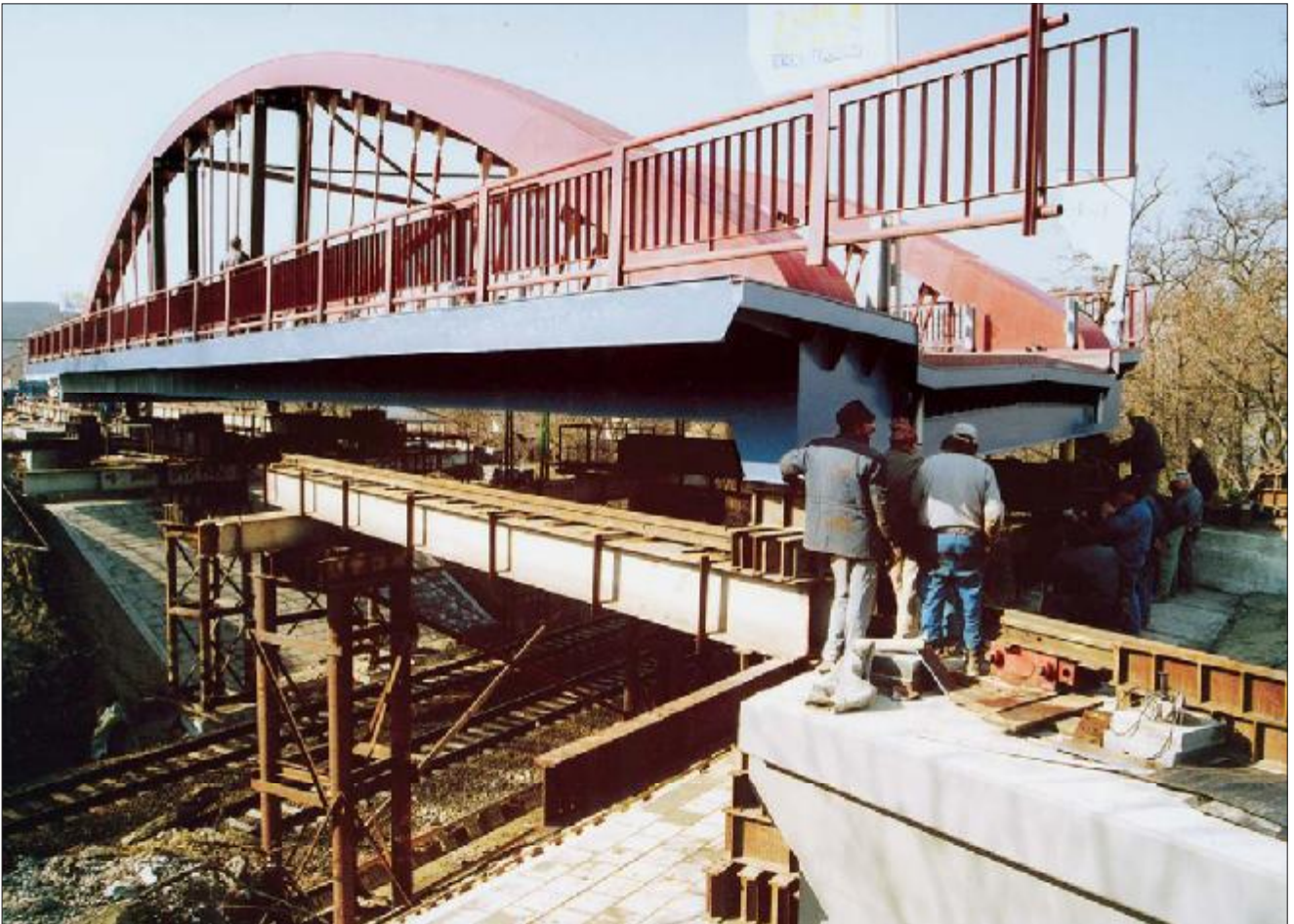
41. kép: A híd betolása befejeződött, folyik a segédberendezések eltávolítása
