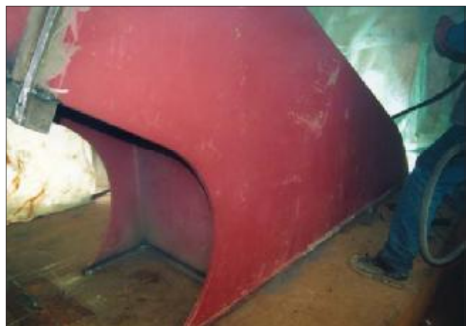
33. kép: Az ívcsomk hegesztése a sátor védelme alatt
