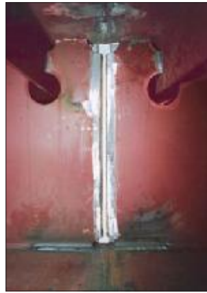
25. kép: A 24. képen látható illesztés a hegesztés felőli oldalról szemlélve
