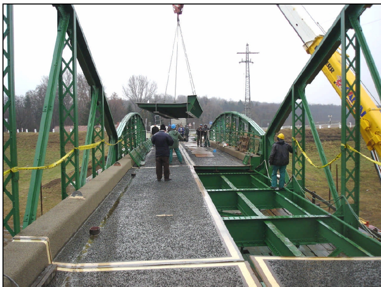
A medernyílás záró pályalemez-elemének beemelése élénk érdeklődés mellett folyt
