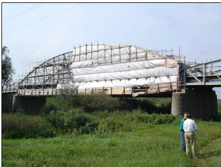
Az acélszemcsés felülettisztítás idejére az állványzatra fóliaterítés került
