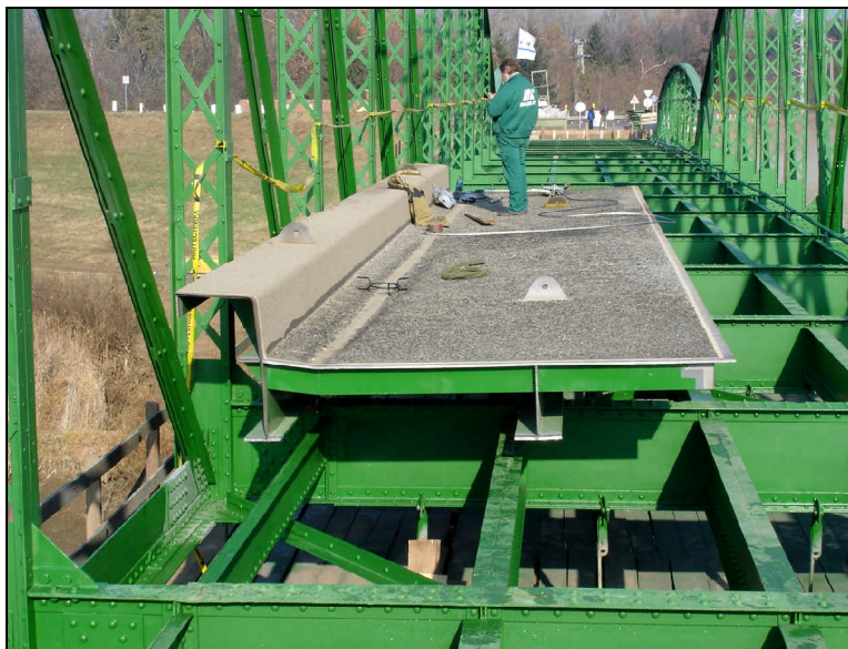
A medernyílás középső pályalemez-elemének behúzása
