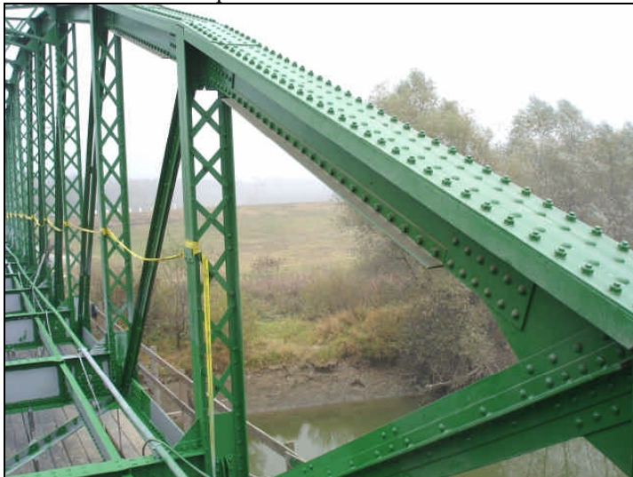
A főtartók felső övének erősítése és az oszlopok hevederezésének sűrítése
