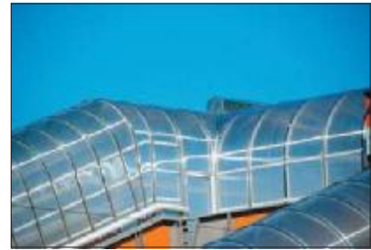
28. kép: A burkoló polikarbonátváz térbeli csomópontja
