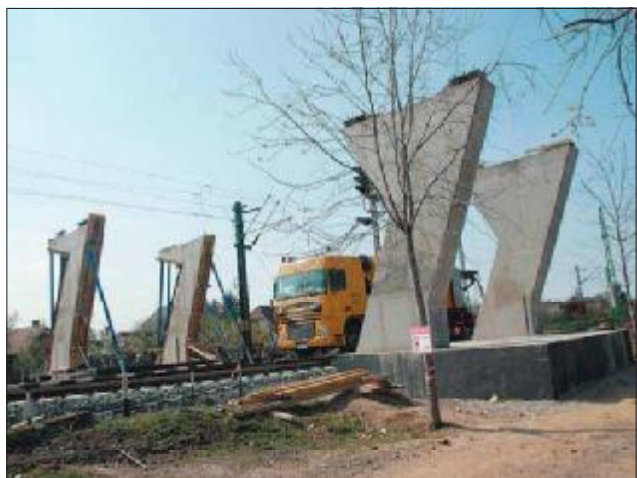
17. kép: Vasbeton alépítmények
