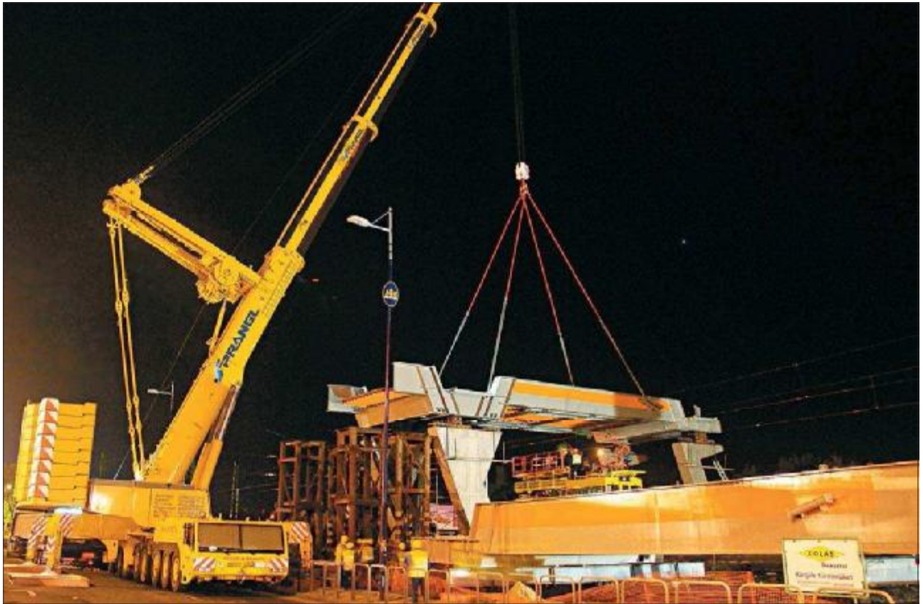
25. kép: A vasútvonal feletti egység emelése
