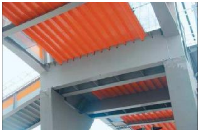
6. kép: Ortotrop pályalemez közbenső támaszkeresztartó részlete
