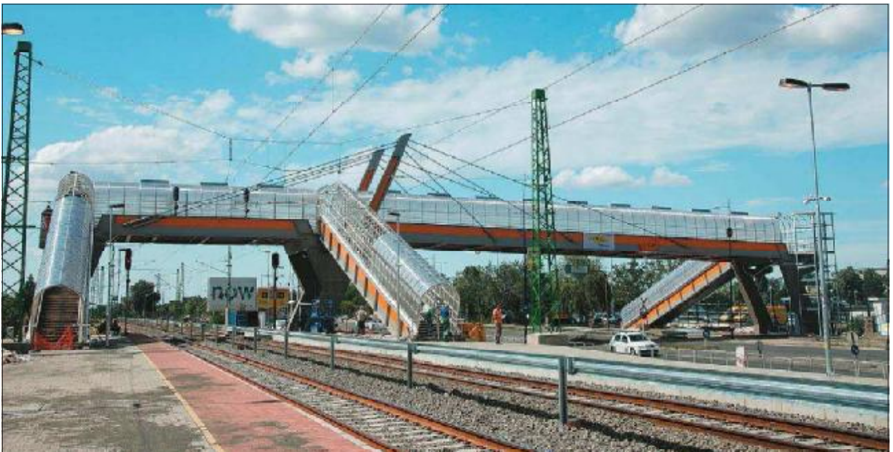
8. kép: A hídszerkezet
