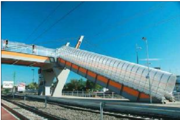
7. kép: Egyenes tengelyű feljáró lépcső (rejtett pihenővel)
