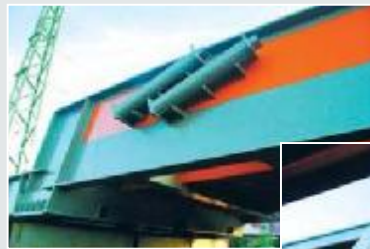
12. kép: A merevítőtartó-kábelhorgonyzás kialakítása, a főtartó külső és belső oldalán
