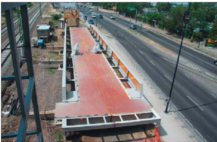
23. kép: A szerelőtér háttérben a már beemelt vasút feletti nyílással és felhegesztett pilonnal
