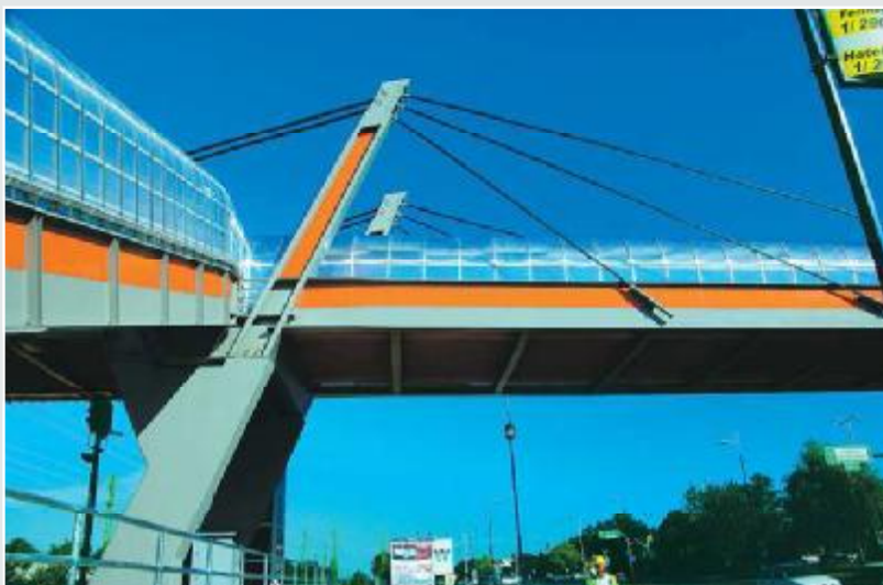
14. kép: A pilon kialakítása
