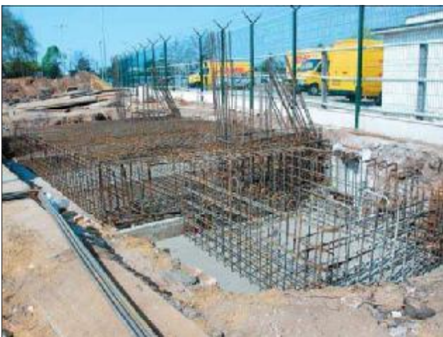
16. kép: Alptest és liftakna betonacél-szerelése
