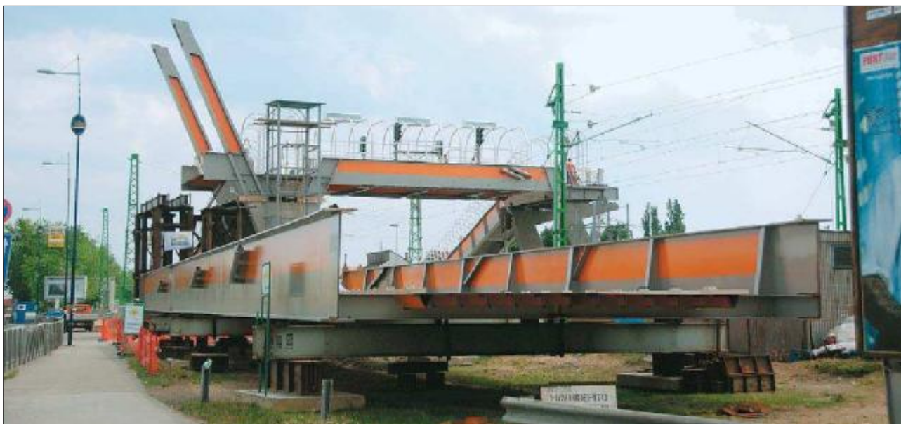
23. kép: A szerelőtér háttérben a már beemelt vasút feletti nyílással és felhegesztett pilonnal
