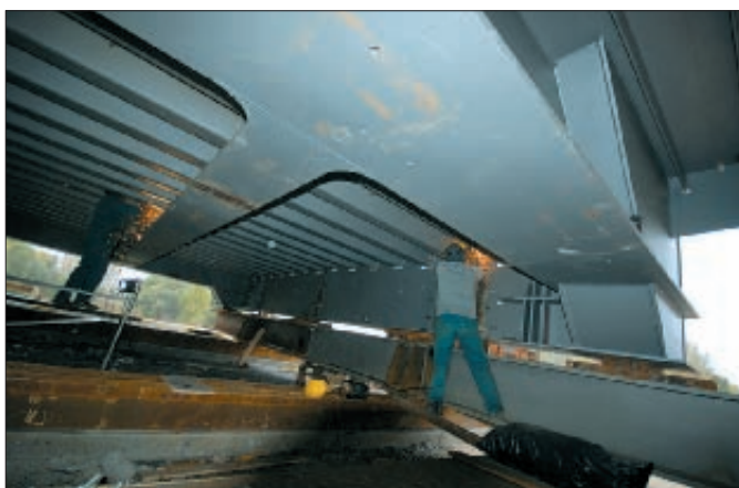
18. kép: Alulnézet: a szállítási egységek helyszíni illesztése, ívcsonk
