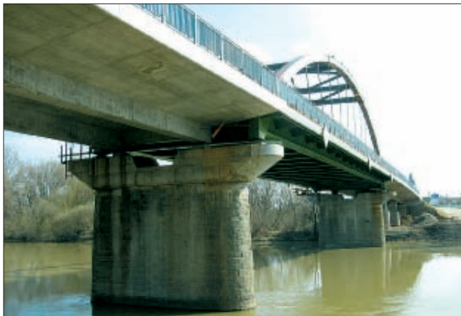
28. kép: A helyére került új hídszerkezet
