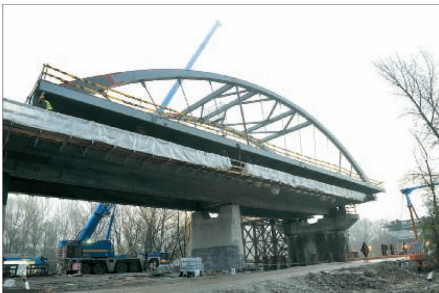
17. kép: Acélhíd szerelése a vasbeton ártéri hídon
