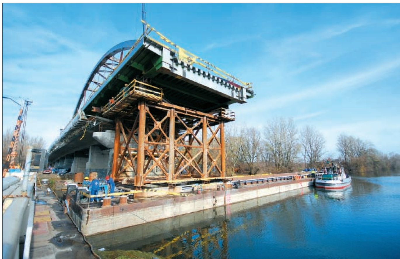
26. kép: Szerkezet már a bárkán, indul a beúsztatás
