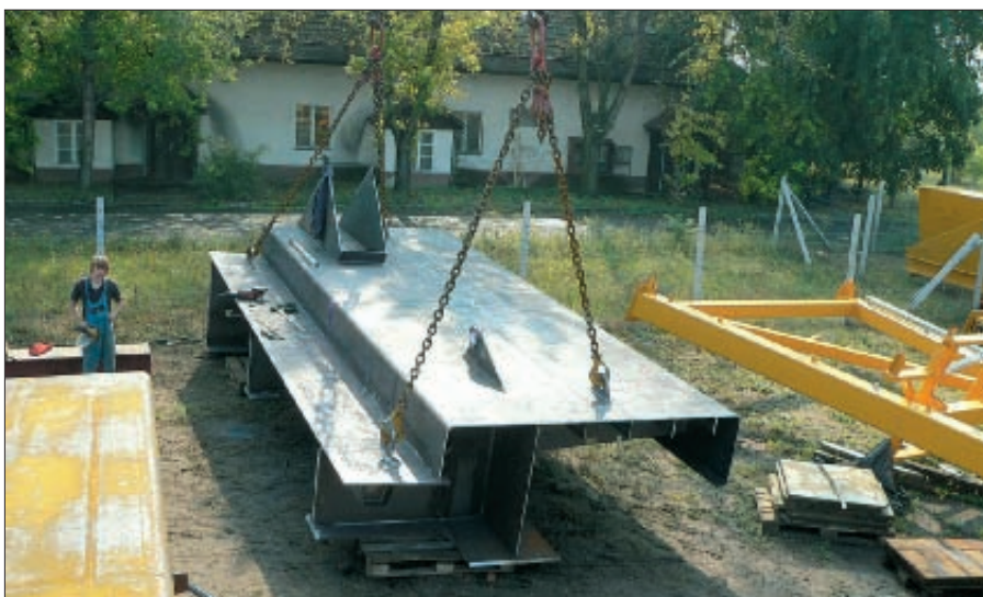
12. kép: Gyártási egység emelése, látható a merevítő- és kereszttartó-kialakítás
