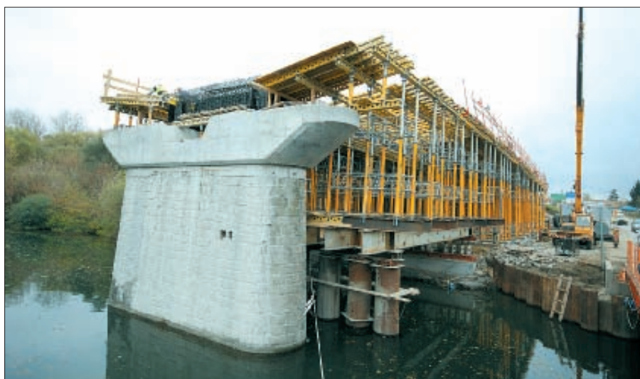
8. kép: Elkészült mederpillér-fejgerenda és a mögötte bezsaluzott ártéri vasbeton híd
