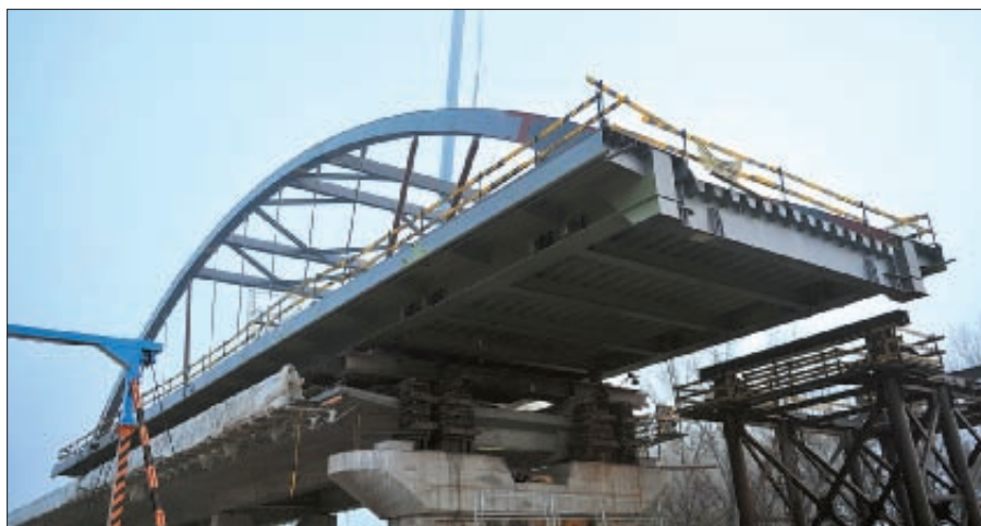
24. kép: Az elkészült mederhíd felszerkezete ívhídként szokatlan statikai állapotban: maximális konzolhosszal kitolva a bárka aláúsztatására vár
