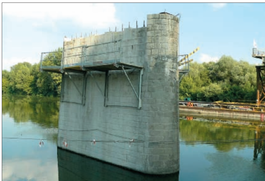
7. kép: A mederpillér átalakítása megkezdődött
