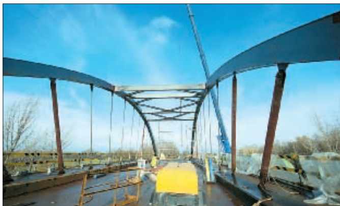
21. kép: Elkészült ívek és merevítéseik, a függesztőrudak egy része nyomásnak ellenálló oszloppal kiváltva
