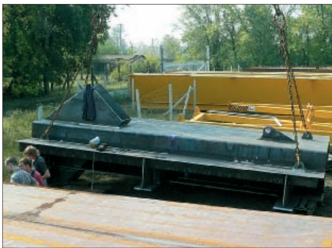
15. kép: Végkereszttartó gyártási egység emelése, a hossz-metszet mutatja a kereszttartó-kiosztást, látható a sugárirányú függesztőrudak első csomólemeze
