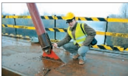
23. kép: Az ideiglenes oszlopbekötés a függesztőrudak csomólemezhöz alkalmazkodik
