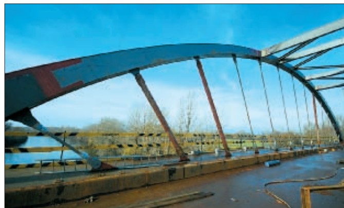
22. kép: A betolás idejére behelyezett, ideiglenes, nyomott oszlopok
