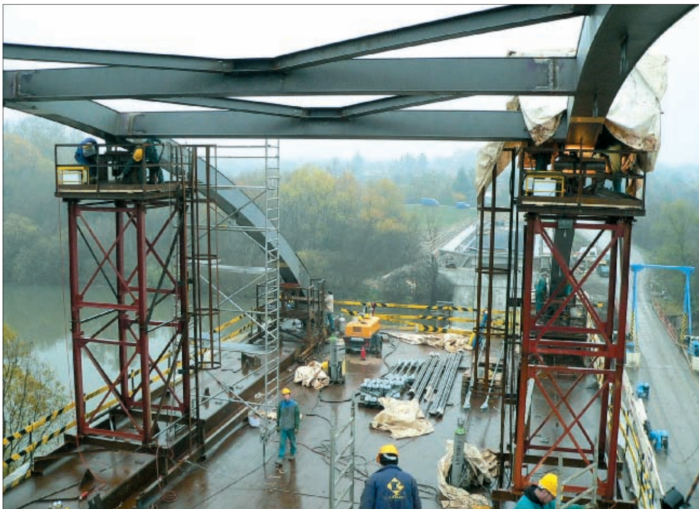
20. kép: Ívek ideiglenes jármokkal alátámasztva, helyszíni illesztések készülnek
