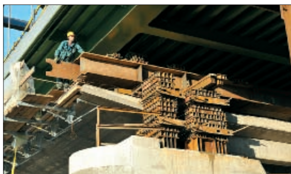
25. kép: Az úsztatás irányítása a mederpillérről, illetve a jelentős magasságkülönbség miatt magas máglyázás
