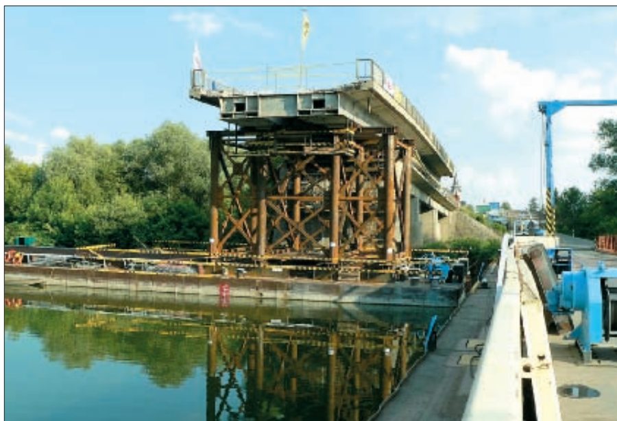
6. kép: A régi mederhíd kiúsztatása 1080 tonnás bárkára telepített állványrendszeren
