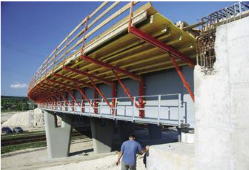
22. kép: Vasbeton pályalemez zsaluzata
