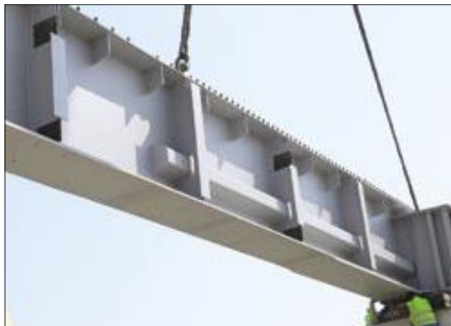
14. kép: Gerinclemez-merevítés a támasz feletti nyomott zónában: trapézlemez
