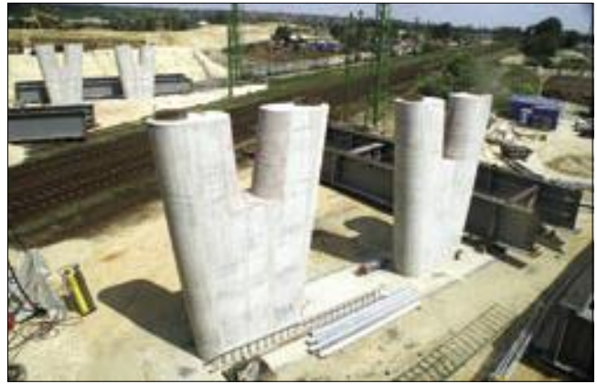
19. kép: Alépítmények és daruzásra váró szerelési egységek
