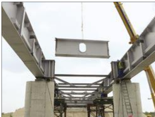
15. kép: 142/k híd helyszíni szerelése: közbenső támaszkeresztartó beemelése
