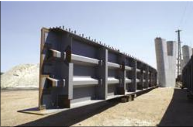
17. kép: Az íves főtartók a helyszínen szereléshez előkészítve
