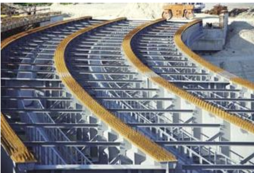
23. kép: Az íves acéltartók „beton nélküli” szépségükben
