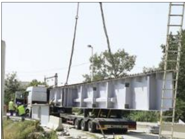
13. kép: Gyártási, szerelési egység beemelésre előkészítve traileren
