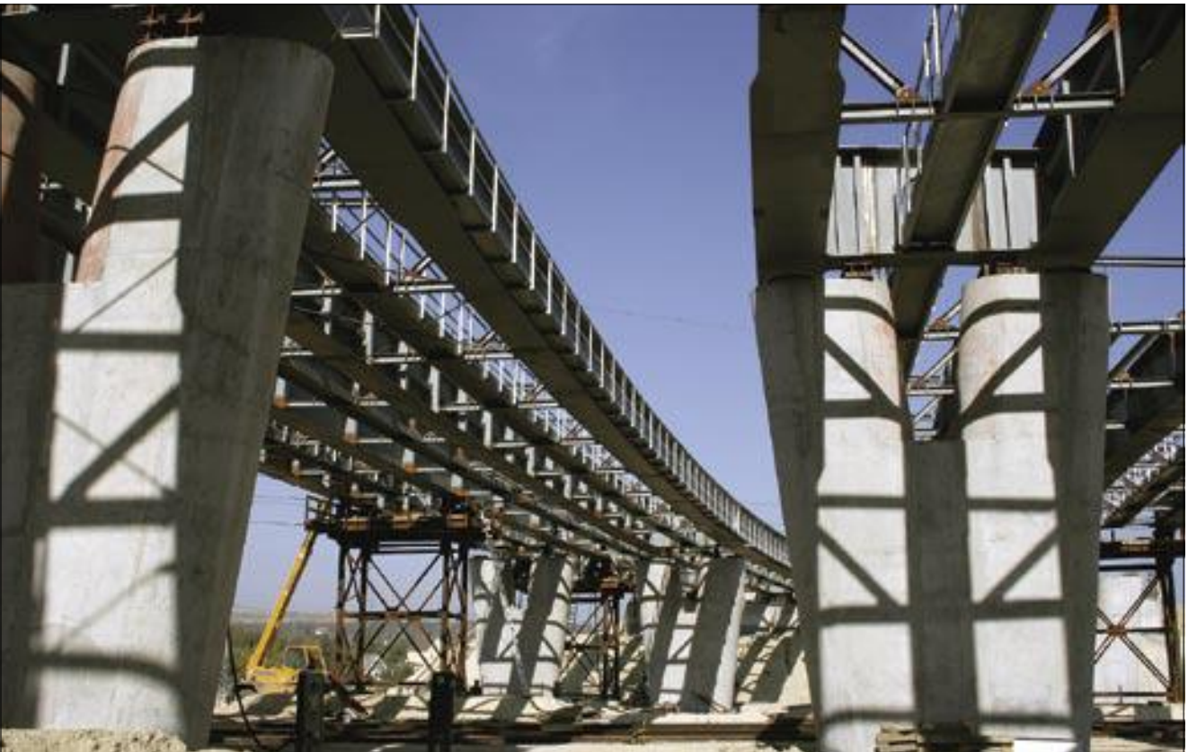
20. kép: Acéltartók szerelése, a segédjármok csak az acélszerkezet szerelését segítették
