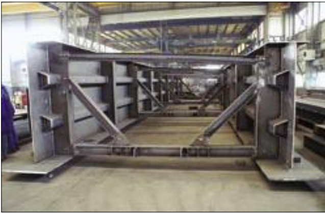
16. kép: 147 j. híd előszerelt főtartópárja az MCE Nyíregyháza Kft. nyíregyházi gyárában
