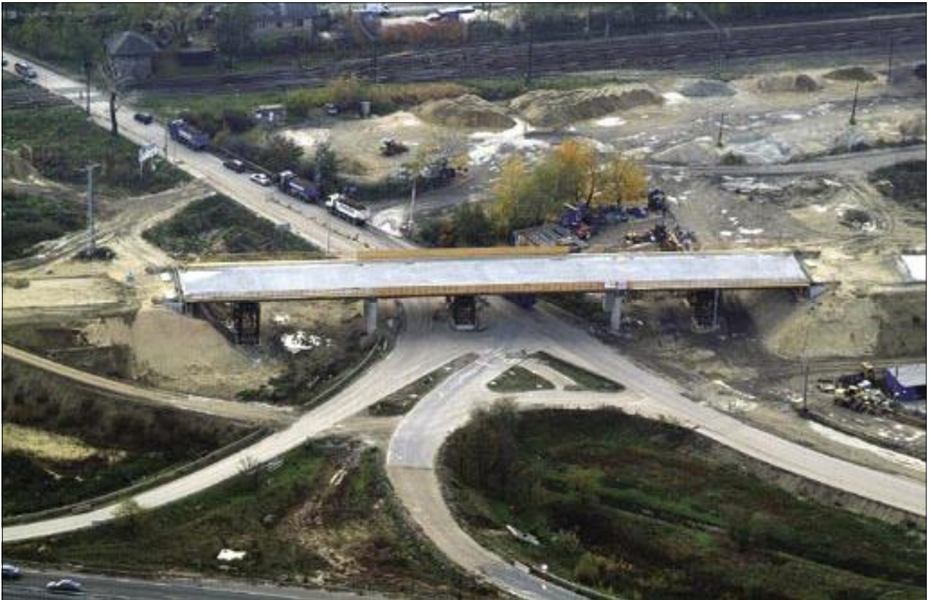
6. kép: A 142 j. híd a már elkészült vasbeton pályalemezzel madártávlatból, látható az arányos nyílásbeosztás, merőleges támaszok, betonozási segédjármok
