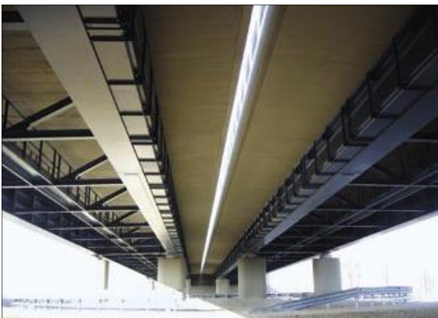
5. kép: Egy hasonló „hagyományos”, két főtartós öszvér felszerkezet: az M30 autópálya vég-csomóponti hídja (2 darab felszerkezet), fajlagos acél-anyagfelhasználás: 128 kg/m 2
