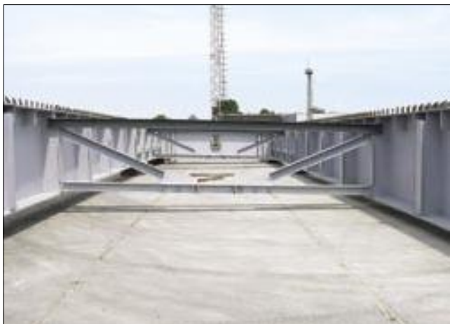
12. kép: 142/k híd előszerelése Dunaújvárosban, a Molnár Zrt. telephelyén
