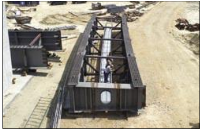
18. kép: Emelési egység összeállítása: végkeresztartós, kereszt-tartókkal összemerevített tartópár
