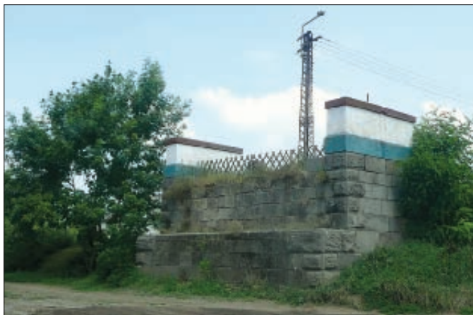
1. kép: A magyar oldali hídfő az újjáépítés előtt
