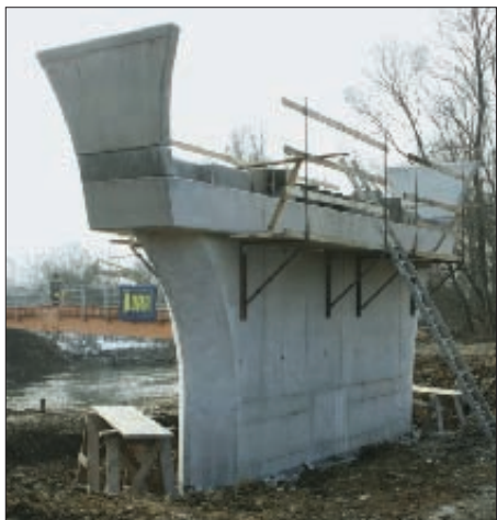
7. kép: A „C” pillér betonszerkezete
