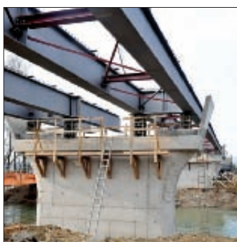
11. kép: Acél főtartók szerelése, ideiglenes keresztartók és szélrácsok az emelési egységekben
