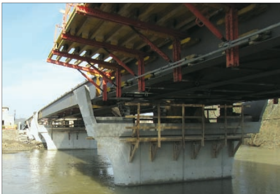
19. kép: A III. emelési egység helyére illesztése, övek és gerincek eltoló toldási helyei
