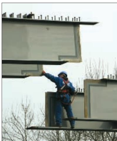
19. kép: A III. emelési egység helyére illesztése, övek és gerincek eltoló toldási helyei
