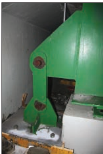
9. kép: Felszerkezet-lekötő acélszerkezet az „A” hídfő befolyási oldali főtartóján
