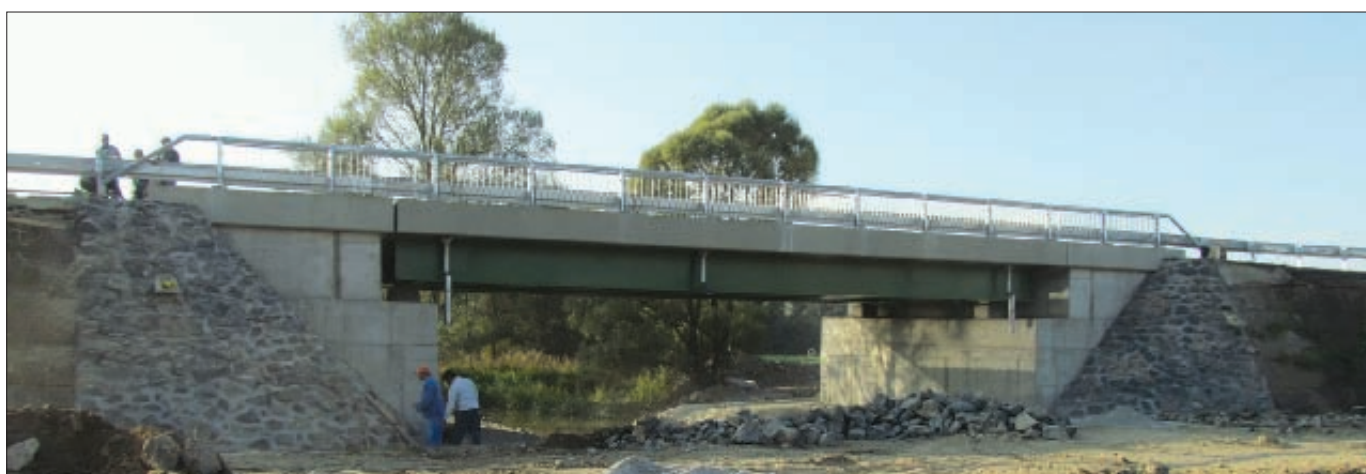
28. kép: Az elkészült patakhíd nézete
