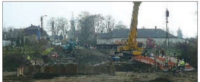
14. kép: A provizórikus híd építése a leendő szerkezet kifolyási oldalán
