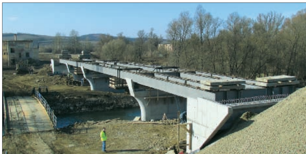
10. kép: Összeszerelt acélszerkezet leterhelésekkel, helyszíni illesztések függőállványával
