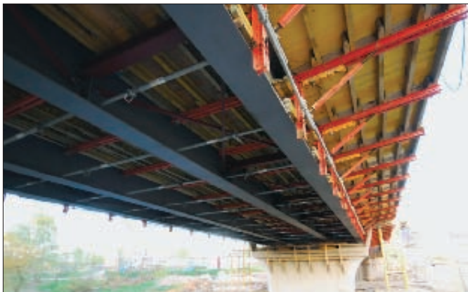
21. kép: Függő pályalemez-zsaluzat. Főtartók közötti keresztirányú kitémasztások
