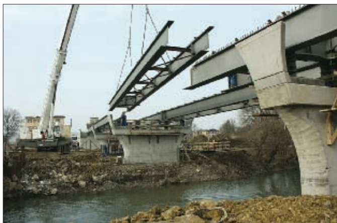
17. kép: A III. jelű egység emelése
