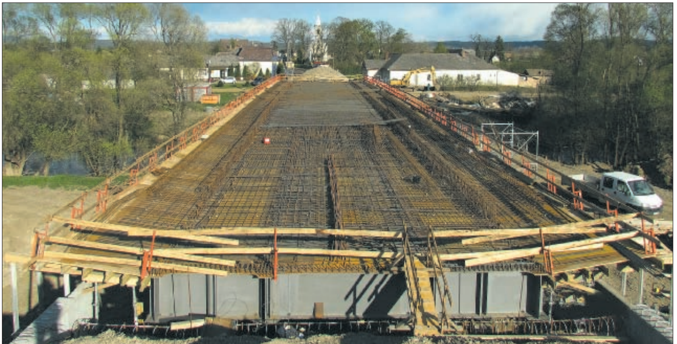
13. kép: A pályalemez vasszerelése
