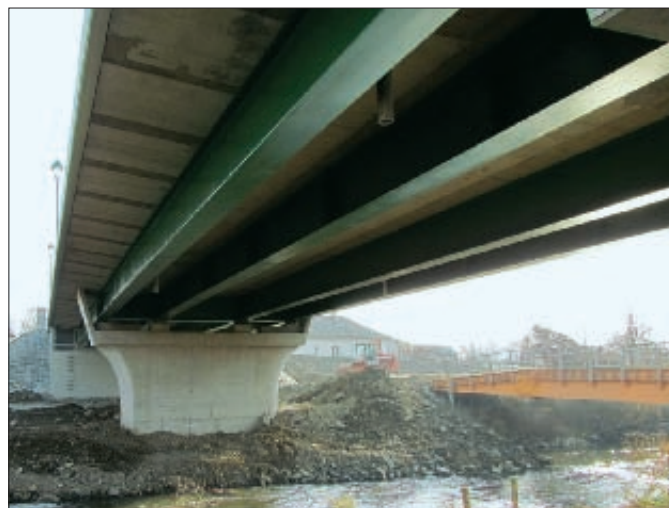
8. kép: Az elkészült mederhíd „B” pillére, főtartónként megtámasztott felszerkezet
