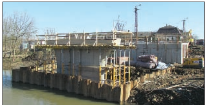
15. kép: Monolitikusan készülő aléptítmények a magyar oldalon
