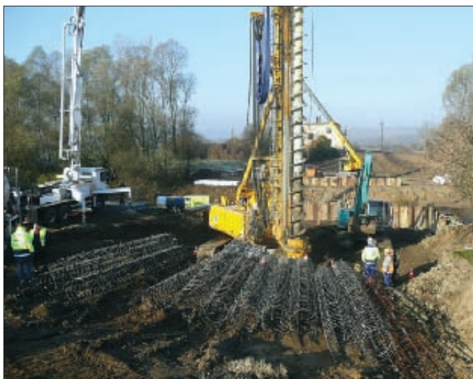
6. kép: Cölöpözési munkák a magyar oldali hídfőnél
