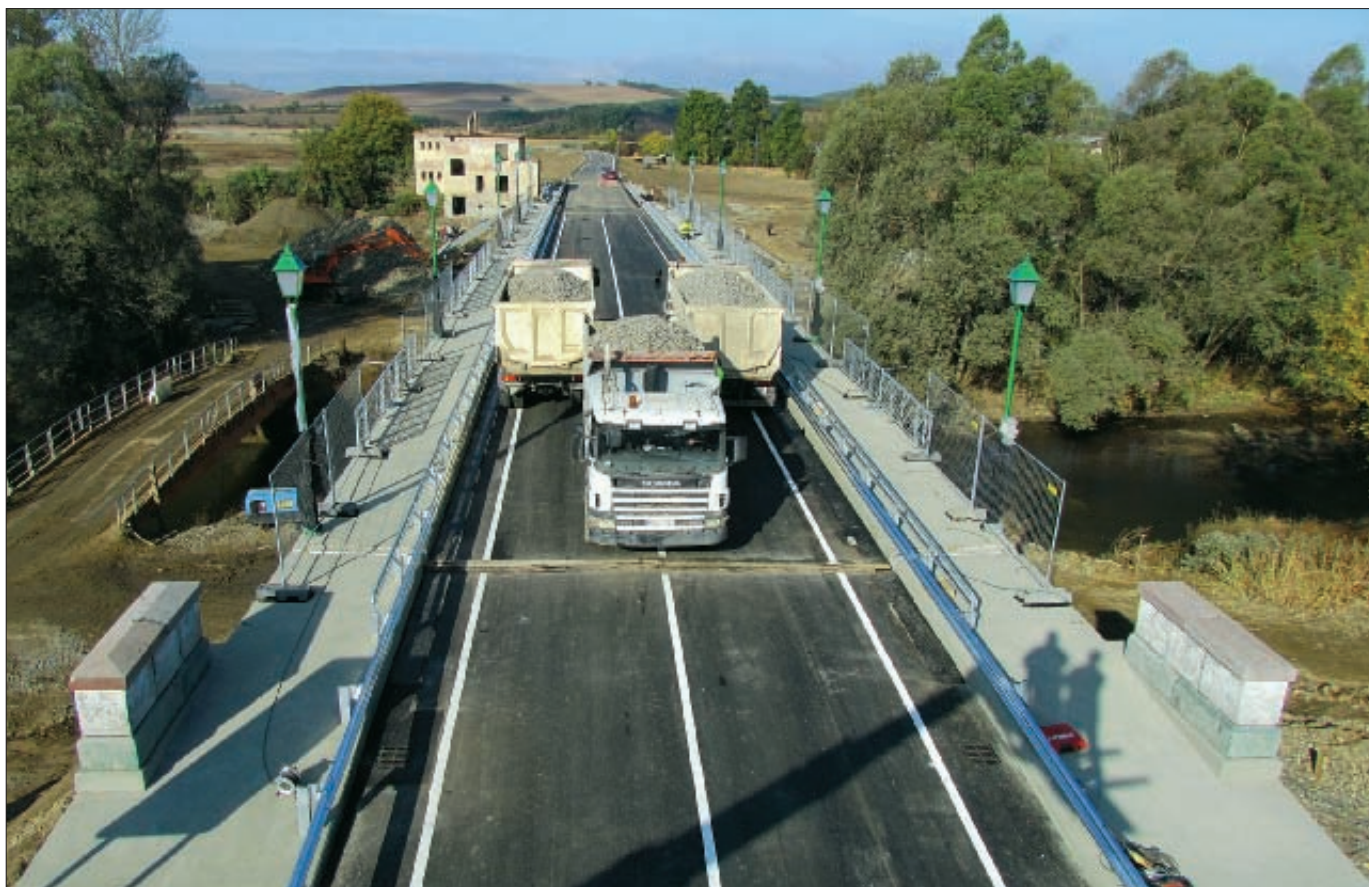
24. kép: Próbaterhelés
