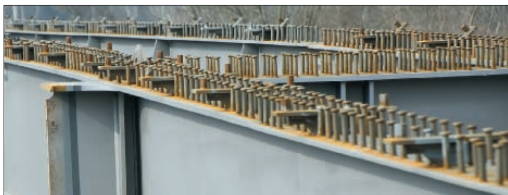
12. kép: Fejes csapok és a pályalemez zsaluzatát tartó acélszerelvények a főtartók felső övének
