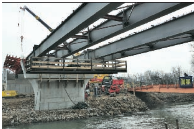
18. kép: Szerelőállvány az Ipoly medre feletti nyílásban
