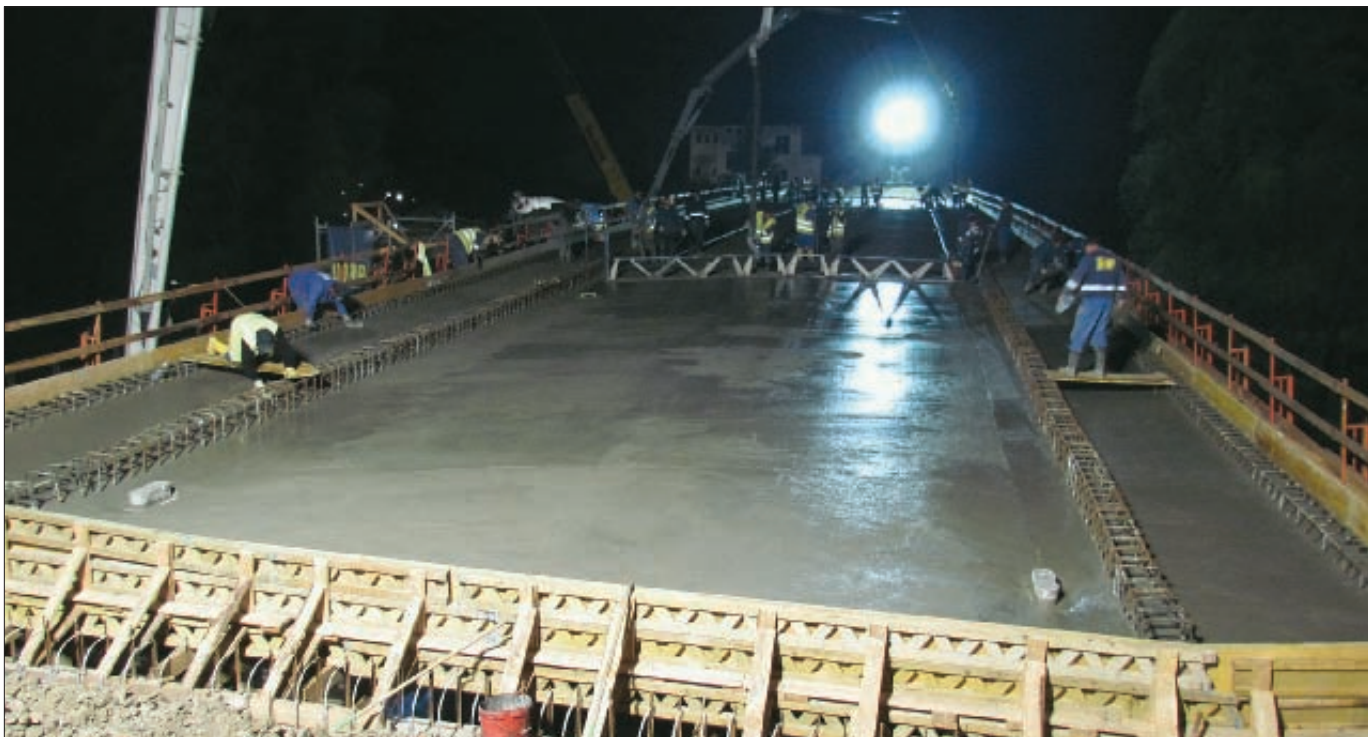
22. kép: Éjszakai kétirányú pályalemez-betonozás
