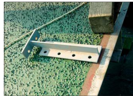
6. kép: A felfekvés alatti erősítő szelvény felrögzítésre vár
