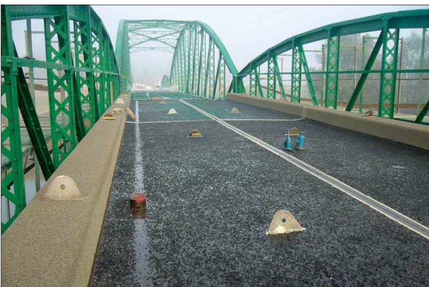
14. kép: Az elhelyezett pályatáblák még a aszfaltozás előtt
