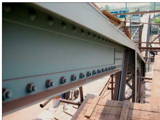
5. kép: A felső öv gerincének erősítése
