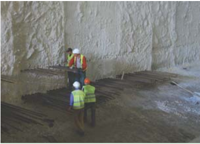
3. kép. Alaplemez síkig együtemű földkiemelés és résfal-alaplemez kapcsolata lentonok alkalmazásával
