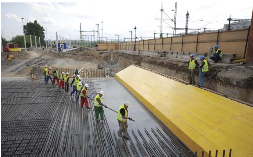
6. kép. Monolit vasbeton lemezhid vasszerelése, látszóbeton zsaluzat
