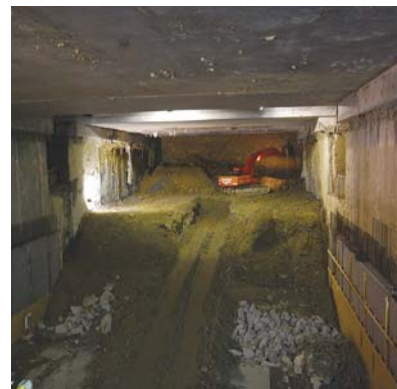
2. kép. Földkiemelés a vasúti hidak alól
