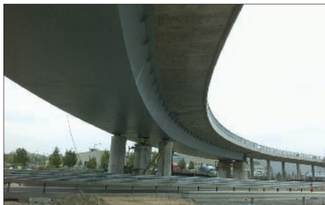
22. kép: A kész hídszerkezet
