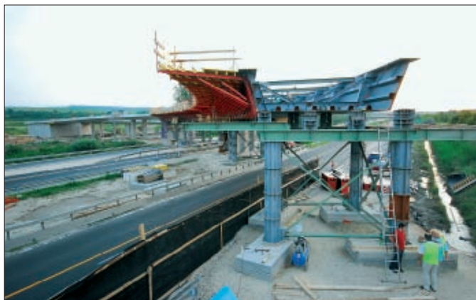
18. kép: A jármokkal alátámasztott acélszerkezet és a pályalemez zsaluzata
