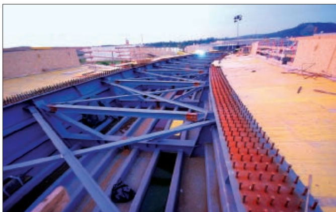
21. kép: A kész acélszerkezet az ideiglenes szélrácsokkal és keresztkötésekkel
