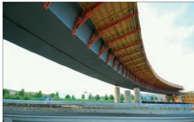
19. kép: Az acélszerkezet alulról és a zsaluzat
