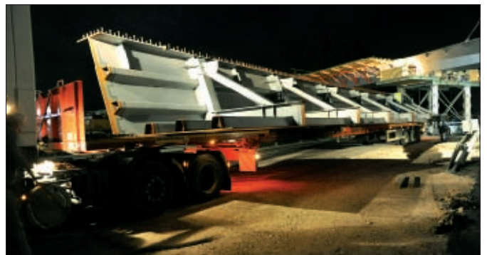
15. kép: Az elemek szállítása a helyszínre
